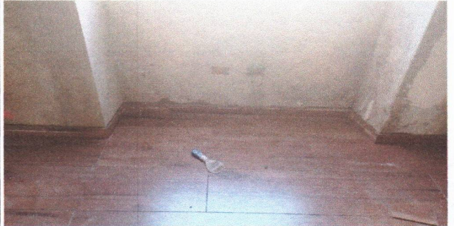
ASSENTAMENTO DO REVESTIMENTO CERÂMICO NO PISO TIPO PORCELANATO E APLICAÇÃO DO RODAPÉ (PREFEITURA SEDE)
