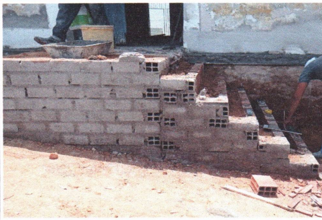
ELEVAÇÃO COM BLOCO CERÂMICO NA RAMPA E ESCADARIA (PREFEITURA SEDE)
