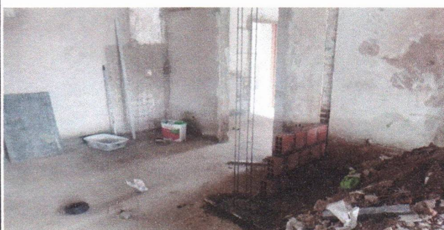
ELEVAÇÃO COM BLOCO CERÂMICO ENTRE O SALÃO PRINCIPAL E A RECEPÇÃO (PREFEITURA SEDE)
