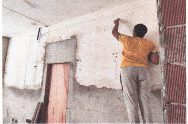
RASPAGEM NA SUPERFÍCIE DAS PAREDES (PREFEITURA SEDE)
