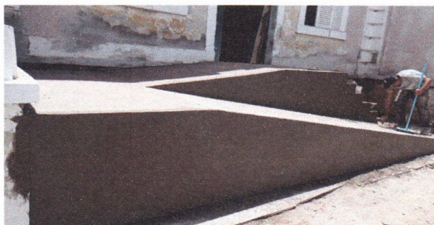
CHAPISCO E MASSA ÚNICA NA RAMPA E ESCADARIA (PREFEITURA SEDE)
