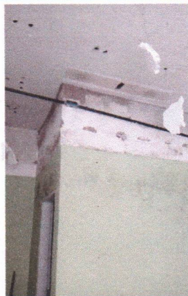
PAREDE A SER DEMOLIDA NO ANTIGO WC DO GABINETE DO PREFEITO (PREFEITURA SEDE)
