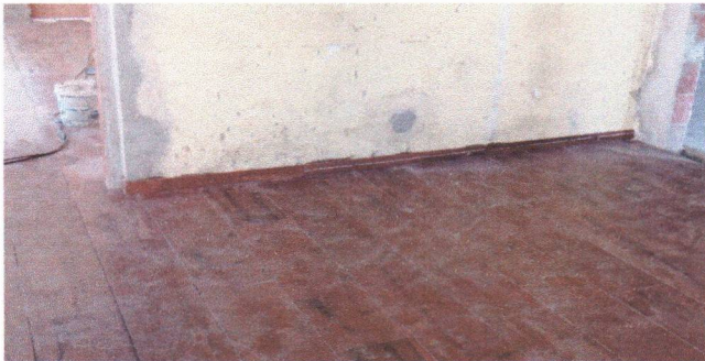
ASSENTAMENTO DO REVESTIMENTO CERÂMICO NO PISO TIPO PORCELANATO E APLICAÇÃO DO RODAPÉ (PREFEITURA SEDE)
