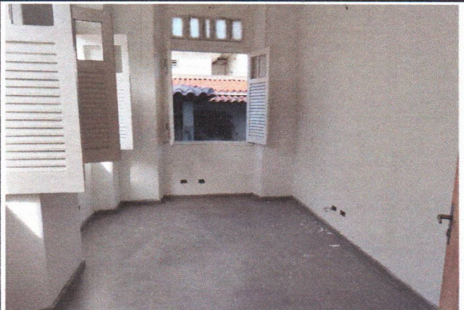
REVESTIMENTO CERÂMICO PORCELANATO NO PISO, RODAPÉ, PONTO ELÉTRICO (ILUMINAÇÃO E TOMADA), PONTO SECO DE LÓGICA, EMASSAMENTO E PINTURA ESMALTE NAS JANELAS (PREFEITURA SEDE)
