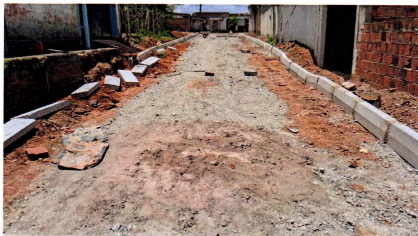
(09) Regularização e Sub Base
