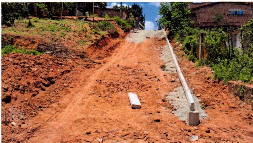
(10) Assentamento de Meio-fio
