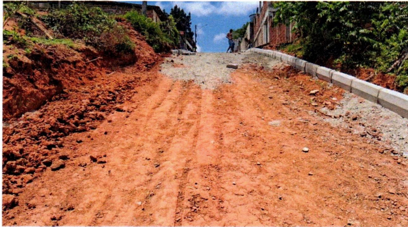
(07) Regularização e Meio-Fio
