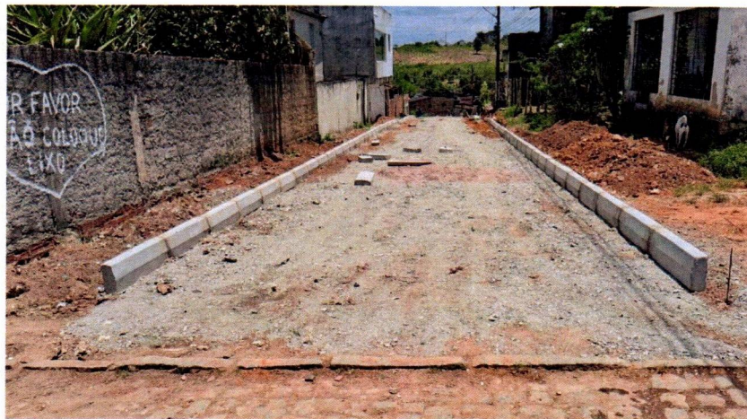
(08) Sub Base e Meio-Fio
