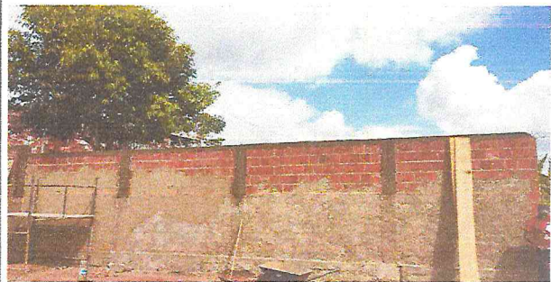
ELEVAÇÃO DA ALVENARIA COM BLOCO CERÂMICO, CONCRETAGEM DOS PILARES, APLICAÇÃO DO CHAPISCO E CONCRETAGEM DA VIGA SUPERIOR
