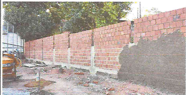
ELEVAÇÃO DA ALVENARIA COM BLOCO CERÂMICO, CONCRETAGEM DOS PILARES E APLICAÇÃO DO CHAPISCO
