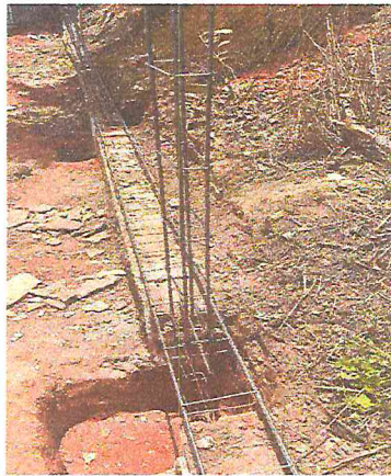
ARMAÇÃO DA CINTA INFERIOR, DO PILAR E DA SAPATA
