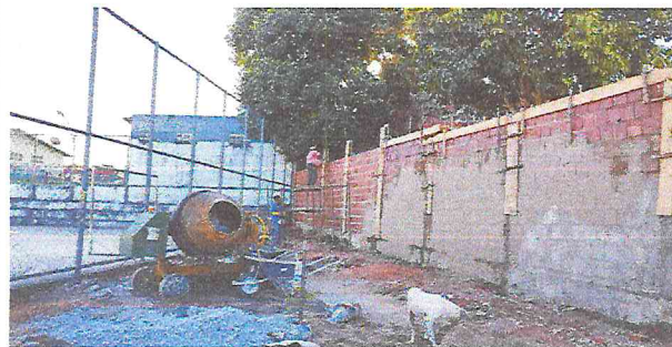
CONCRETAGEM DOS PILARES E DA VIGA SUPERIOR
