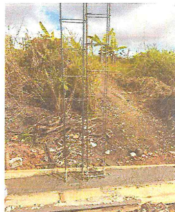
CONCRETAGEM DA CINTA INFERIOR E SAPATA (PILAR DUPLO)
