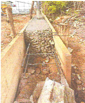
CONCRETAGEM DA CINTA INFERIOR
