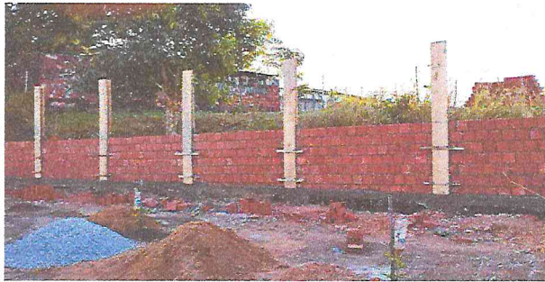
ELEVAÇÃO DA ALVENARIA COM BLOCO CERÂMICO E CONCRETAGEM DOS PILARES
