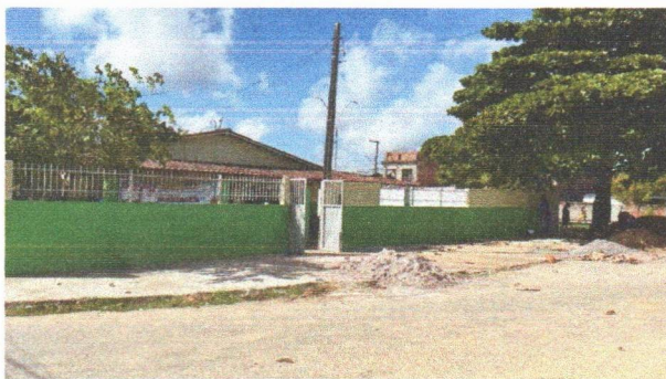
ESCOLA MUNICIPAL VOVÓ ISAURA - PINTURA DO MURO, DO PORTÃO E DO GRADIL
