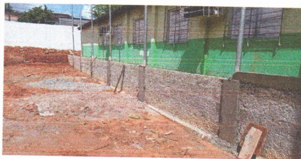
ESCOLA MUNICIPAL ERCINA LAPENDA - ALVENARIA, CHAPISCO, CINTA INFERIOR, PILARES, CHAPISCO (QUADRA)
