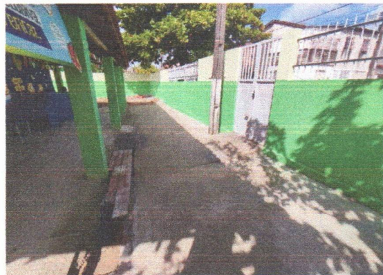
ESCOLA MUNICIPAL VOVÓ ISAURA - PISO DE CONCRETO E CANALETA EM ALVENARIA, PINTURA DO MURO E DAS ESQUADRIAS DE FERRO
