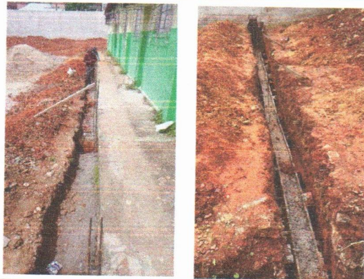
ESCOLA MUNICIPAL ERCINA LAPENDA - ESCAVAÇÃO E BASE EM ALVENARIA (QUADRA)
