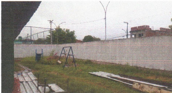
ESCOLA MUNICIPAL VOVÓ ISAURA - PINTURA DO MURO COM SELADOR
