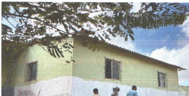
ESCOLA MUNICIPAL SENADOR FRANCISCO GOMES DE ARAÚJO - GRADE DE PROTEÇÃO PINTADA (ZARCÃO E ESMALTE), APLICAÇÃO DE SELADOR
