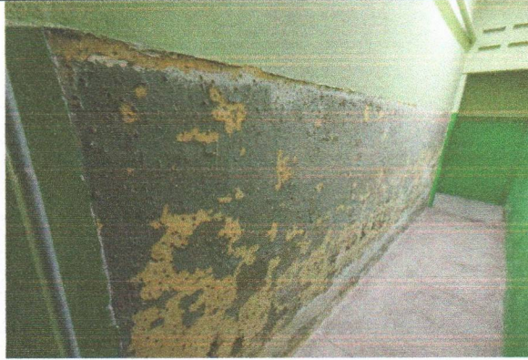
ESCOLA MUNICIPAL INÁCIO GOMES DA SILVA - REMOÇÃO DE REVESTIMENTO CERÂMICO
