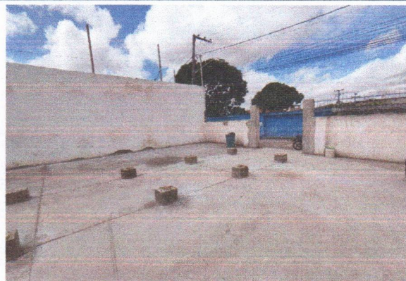
ESCOLA MUNICIPAL INÁCIO GOMES DA SILVA - PISO DE CONCRETO NA ENTRADA, PILARES EM CONCRETO (CHAPISCADO E REBOCADO) E REMOÇÃO DO PORTÃO DE ENTRADA
