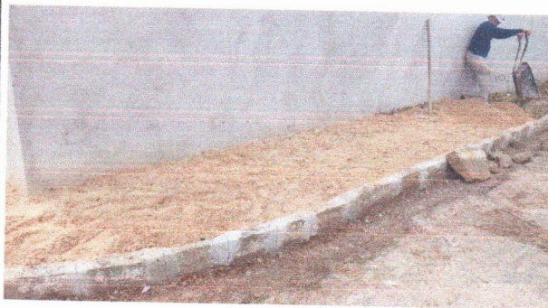
ESCOLA MUNICIPAL ERCINA LAPENDA - ATERRO MANUAL E APLICAÇÃO DE SELADOR NO MURO
