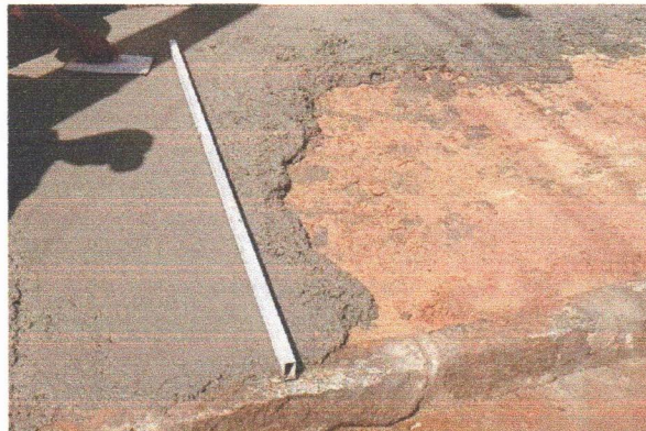
ESCOLA MUNICIPAL VOVÓ ISAURA - ATERRO MANUAL E EXECUÇÃO DE PASSEIO (CALÇADA) OU PISO DE CONCRETO MOLDADO IN LOCO
