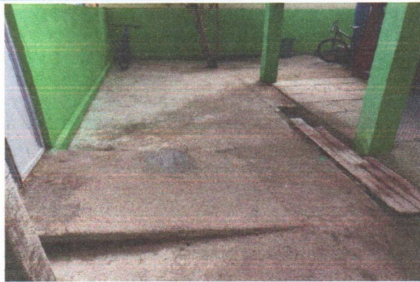
ESCOLA MUNICIPAL VOVÓ ISAURA - PISO DE CONCRETO E CANALETA EM ALVENARIA
