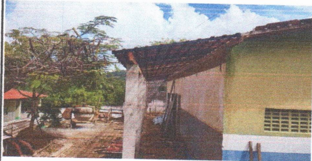
ESCOLA MUNICIPAL FRANCISCO TAVARES - INSTALAÇÃO DE TRAMA NO CORREDOR (BLOCO A)
