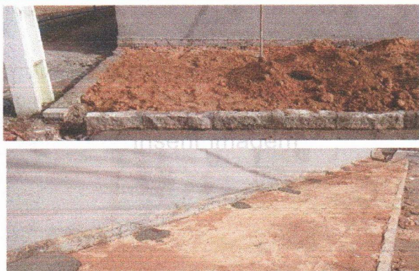
ESCOLA MUNICIPAL VOVÓ ISAURA - ATERRO MANUAL E EXECUÇÃO DE PASSEIO (CALÇADA) OU PISO DE CONCRETO MOLDADO IN LOCO
