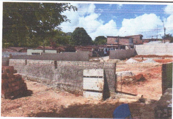
ESCOLA MUNICIPAL ERCINA LAPENDA - ALVENARIA, CHAPISCO, CINTA INFERIOR, PILARES (QUADRA)
