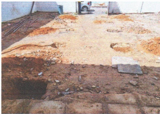
ESCOLA MUNICIPAL INÁCIO GOMES DA SILVA - ESCAVAÇÃO DAS BASES DOS PILARES PARA A PASSARELA
