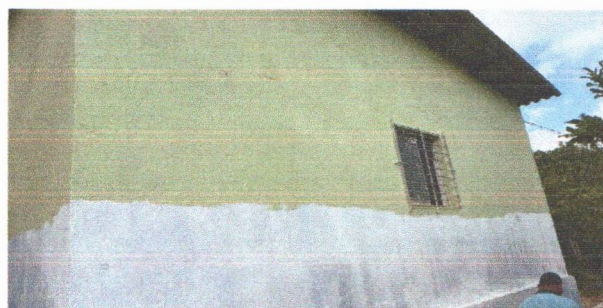
ESCOLA MUNICIPAL SENADOR FRANCISCO GOMES DE ARAÚJO - GRADE DE PROTEÇÃO PINTADA (ZARCÃO E ESMALTE), APLICAÇÃO DE SELADOR
