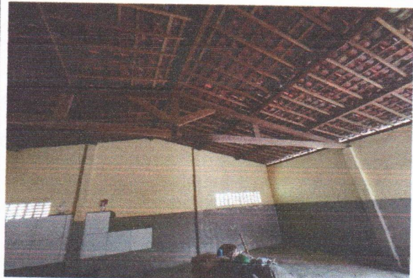
ESCOLA MUNICIPAL FRANCISCO TAVARES - RETELHAMENTO (BLOBO A)
