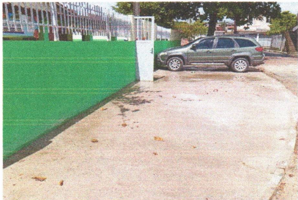
ESCOLA MUNICIPAL VOVÓ ISAURA - EXECUÇÃO DE PASSEIO (CALÇADA) OU PISO DE CONCRETO MOLDADO IN LOCO, PINTURA DO MURO E DO GRADIL
