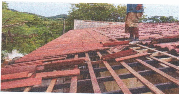
ESCOLA MUNICIPAL FRANCISCO TAVARES - TELHAMENTO COM TELHA CERÂMICA NO CORREDOR (BLOCO A)
