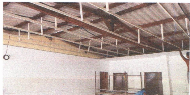
ESCOLA MUNICIPAL SENADOR FRANCISCO GOMES DE ARAÚJO - EMASSAMENTO, REVESTIMENTO CERÂMICO, FORRO PVC
