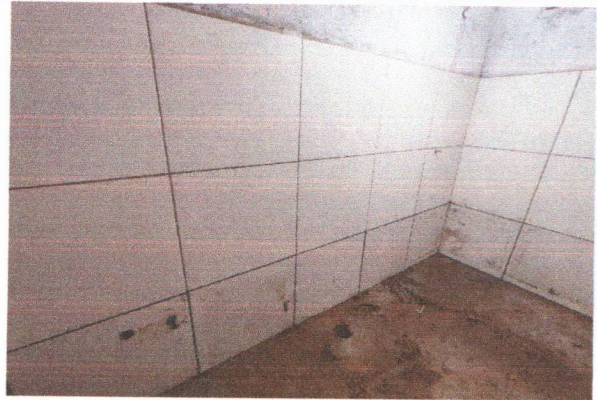
ESCOLA MUNICIPAL SENADOR FRANCISCO GOMES DE ARAÚJO - CERÂMICA NAS PAREDES DOS BANHEIROS, SELADOR, PONTO DE ÁGUA E ESGOTO
