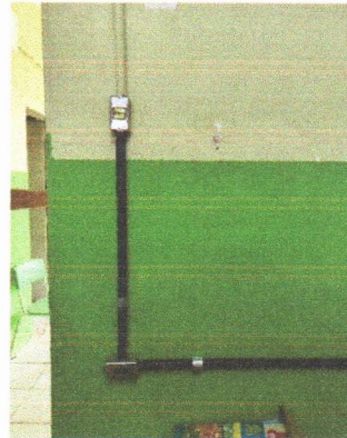
ESCOLA MUNICIPAL INÁCIO GOMES DA SILVA - PONTO DE INTERRUPTOR DUPLO APARENTE E PONTO DE TOMADA SIMPLES APARENTE
