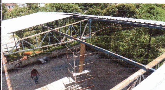
ESCOLA MUNICIPAL ROSINA LABANCA - RETIRADA DE TELHAS METÁLICAS
