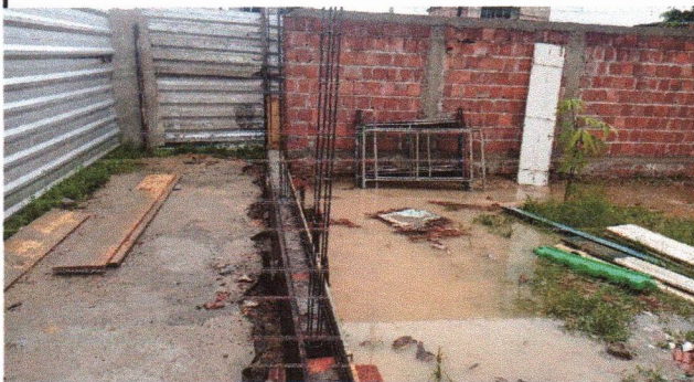
ESCOLA MUNICIPAL VOVÓ ISaura - EXECUÇÃO DE VIGA BALDRAME, ALVENARIA 20 CM DE ESPESSURA, ARMAÇÃO DE PILARES
