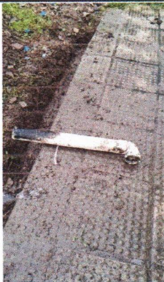
ESCOLA MUNICIPAL CARMELA ORRICO LAPENDA - LIMPEZA DE CAIXA DE GORDURA E DE PASSAGEM
