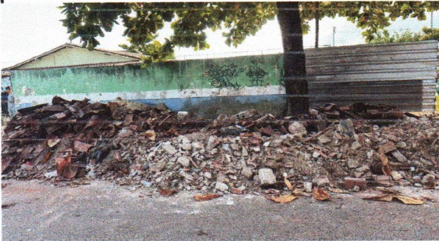
ESCOLA MUNICIPAL VOVÓ ISaura - DEMOLIÇÃO E TRANSPORTE DE ENTULHO
