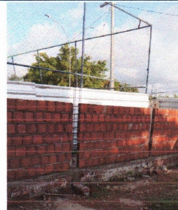
ESCOLA MUNICIPAL VOVÓ ISaura - EXECUÇÃO DE VIGA BALDRAME, ALVENARIA 20 CM DE ESPESSURA, ARMAÇÃO DE PILARES
