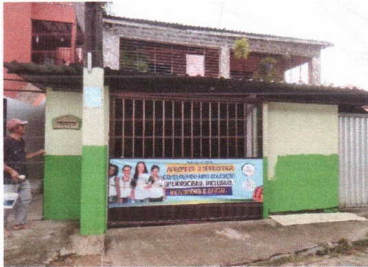
CRECHE MUNICIPAL TIO DUDU - PINTURA LÁTEX ACRÍLICA STANDARD, APLICAÇÃO MANUAL EM PAREDE.
