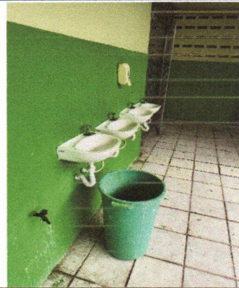
ESCOLA MUNICIPAL INÁCIO GOMES DA SILVA - INSTALAÇÃO DE PIAS, TORNEIRAS, SIFÕES, ENGATES
