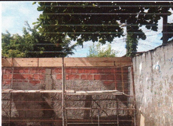
ESCOLA MUNICIPAL VOVÓ ISaura - EXECUÇÃO DE ALVENARIA E CINTA DE AMARRAÇÃO
