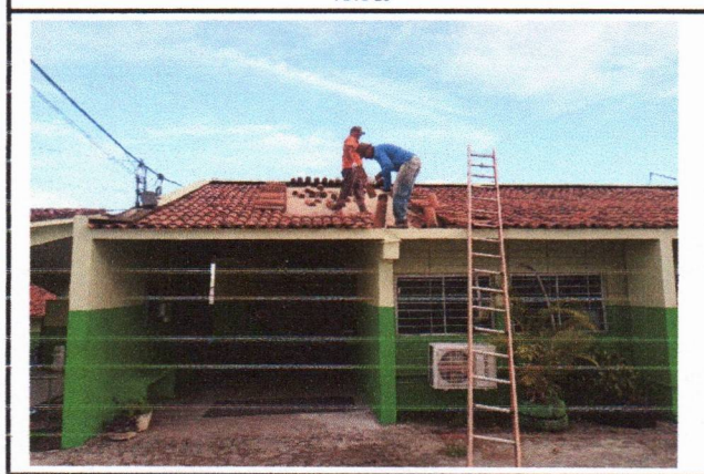
ESCOLA MUNICIPAL APOLÔNIO SALES - RETIRADA E RECOLOCAÇÃO DE TELHA CANAL
