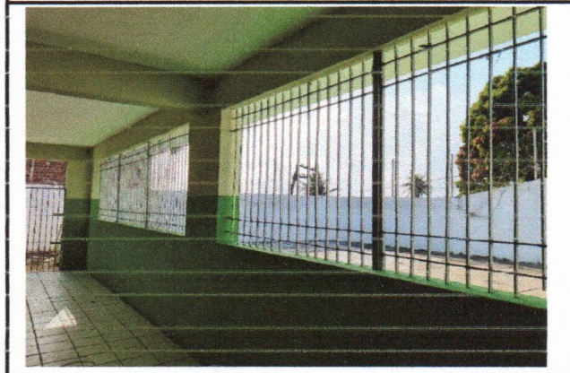
ESCOLA MUNICIPAL INÁCIO GOMES DA SILVA - PINTURA EM PAREDES E TETO
