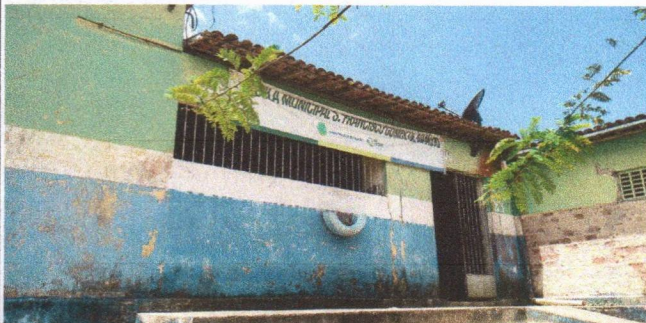
REMOÇÃO DAS TELHAS
