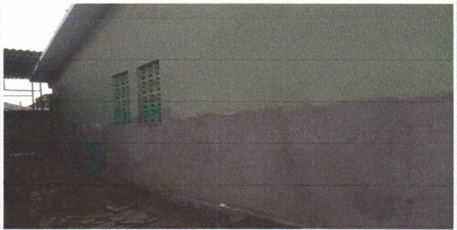
ANTES DA PINTURA
