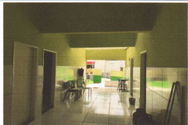
APLICAÇÃO DE KIT ALIZAR, PINTURA EM TETO E EM PAREDES NOS AMBIENTES INTERNOS
