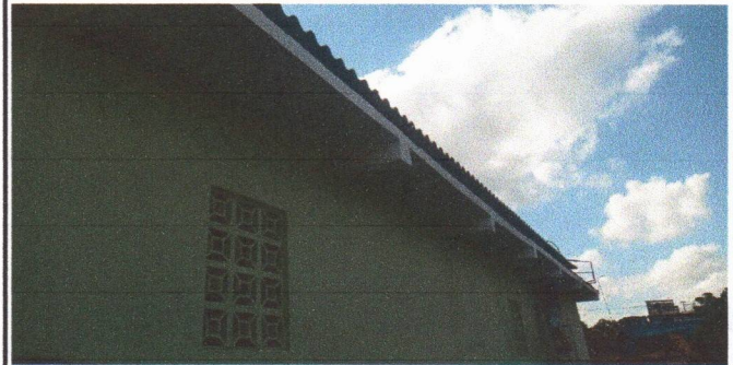
APLICAÇÃO DA PINTURA NAS ÁREAS EXTERNAS
