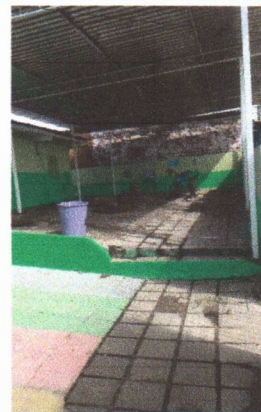
APLICAÇÃO DE PINTURA ESMALTE NA ESTRUTURA METÁLICA DA COBERTA
