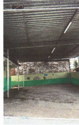
ANTES DA PINTURA
