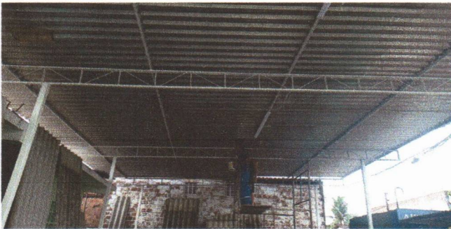
APLICAÇÃO DE PINTURA ESMALTE NA ESTRUTURA METÁLICA DA COBERTA
