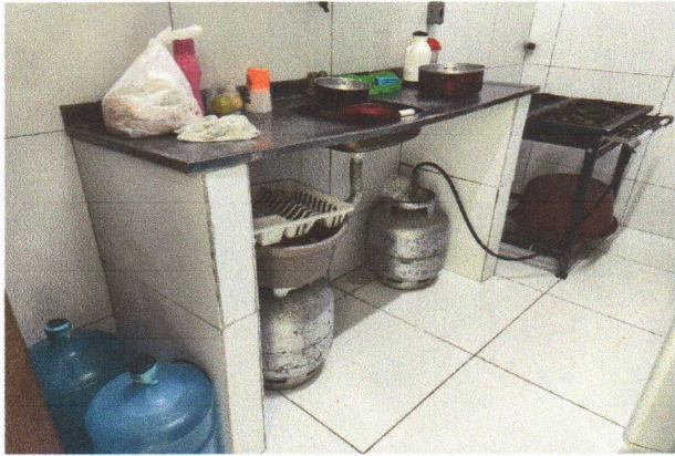
ASSENTAMENTO DO REVESTIMENTO CERÂMICO NA MURETA DA PIA DA COZINHA
