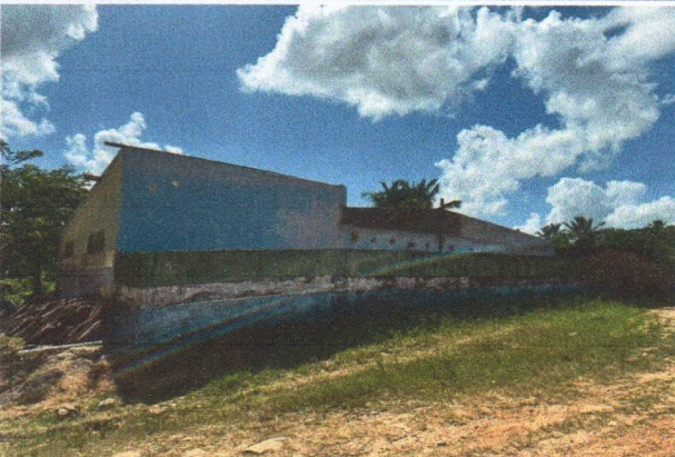
APLICAÇÃO DO CHAPISCO E DA MASSA ÚNICA
