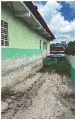
ANTES DA PINTURA
