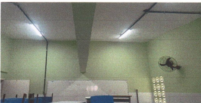
PINTURA EM TETO E EM PAREDES NOS AMBIENTES INTERNOS
