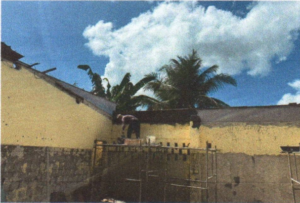
APLICAÇÃO DO CHAPISCO E DA MASSA ÚNICA
