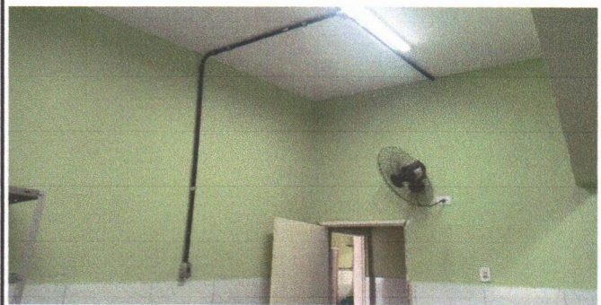
PINTURA EM TETO E EM PAREDES NOS AMBIENTES INTERNOS
