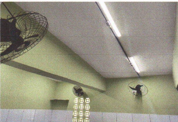
PINTURA EM TETO E EM PAREDES NOS AMBIENTES INTERNOS
