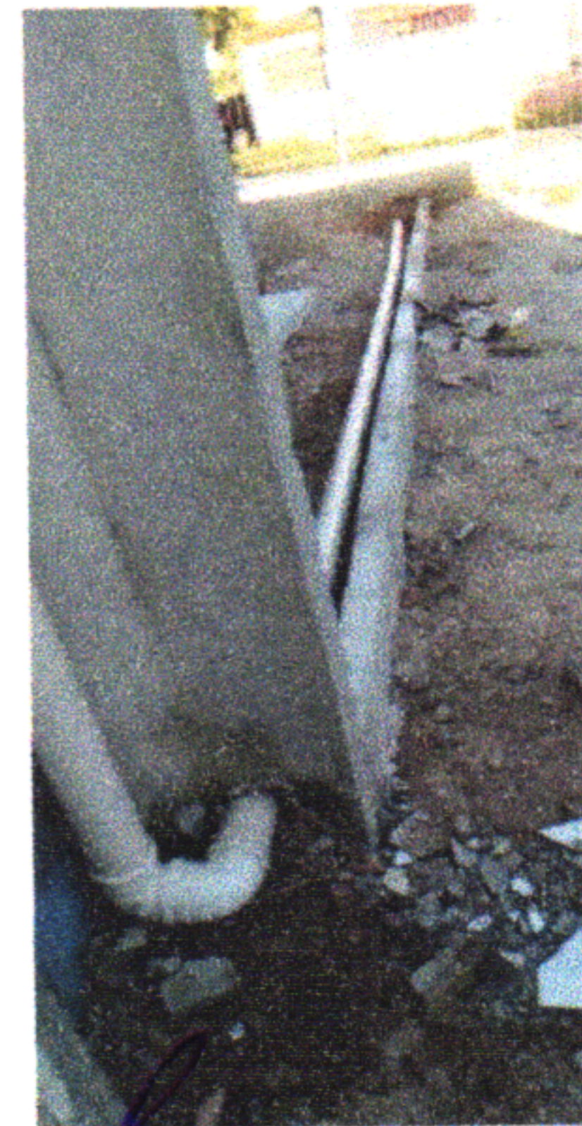
1.6.5 TUBOS DE PVC PARA AGUA PLUVIAL
