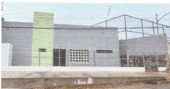
REVESTIMENTO CERÂMICO NA SALA ODONTOLÓGICA
