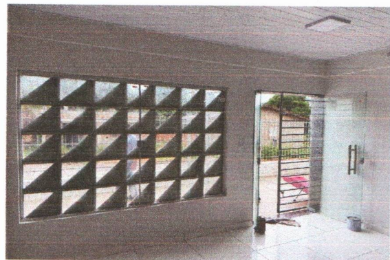
REVESTIMENTO CERÂMICO NA SALA ODONTOLÓGICA
