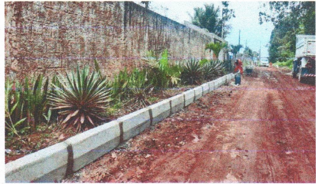
ASSENTAMENTO DE GUIA (MEIO-FIO)
