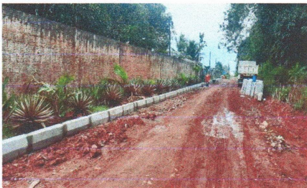
ASSENTAMENTO DE GUIA (MEIO-FIO)
