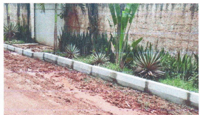
ASSENTAMENTO DE GUIA (MEIO-FIO) LOCAÇÃO
