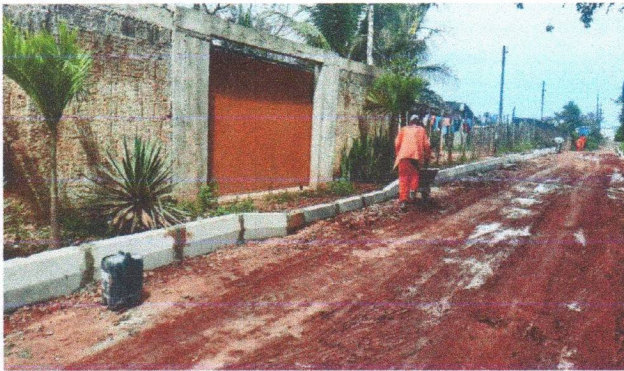
ASSENTAMENTO DE GUIA (MEIO-FIO)
