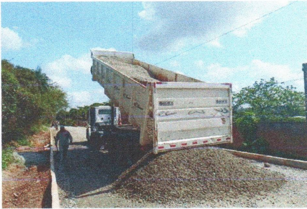
EXECUÇÃO E COMPACTAÇÃO DE BASE DE BRITA GRADUADA SIMPLES
