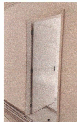
EMASSAMENTO E PINTURA ESMALTE NAS PORTAS (ANEXO FUNDOS)
