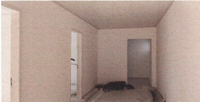
APLICAÇÃO DE PINTURA NAS PARDES (ANEXO FUNDOS)
