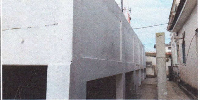
APLICAÇÃO DO SELADOR ACRÍLICO (ANEXO FUNDOS)
