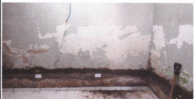
RASPAGEM DA PINTURA (ANEXO FUNDOS)
