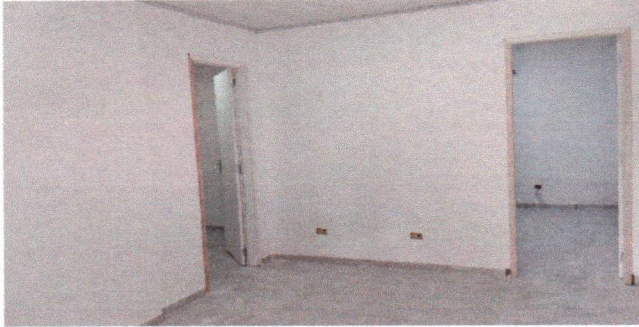
APLICAÇÃO DE PINTURA NAS PARDES (ANEXO FUNDOS)
