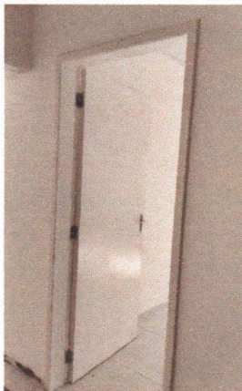
EMASSAMENTO E PINTURA ESMALTE NAS PORTAS (ANEXO FUNDOS)
