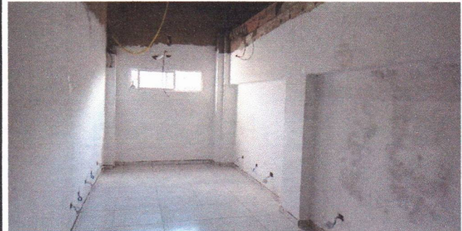
EMASSAMENTO NAS PAREDES (ANEXO FUNDOS)
