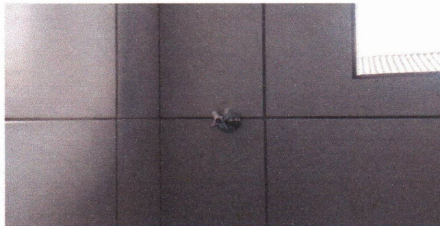
REGISTRO DE PASSAGEM WC 01 (ANEXO FUNDOS)
