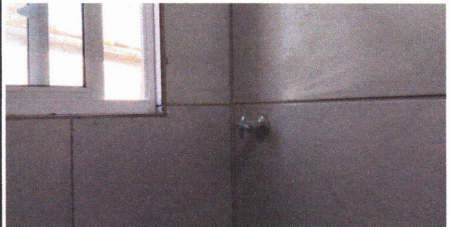
REGISTRO DE PASSAGEM WC 03 (ANEXO FUNDOS)
