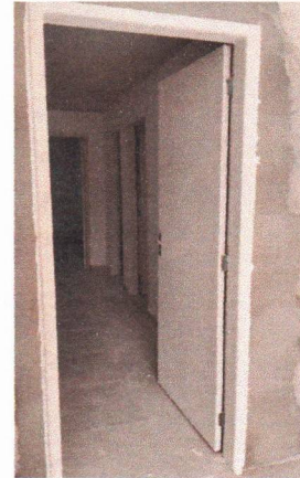
EMASSAMENTO NAS PORTAS (ANEXO FUNDOS)
