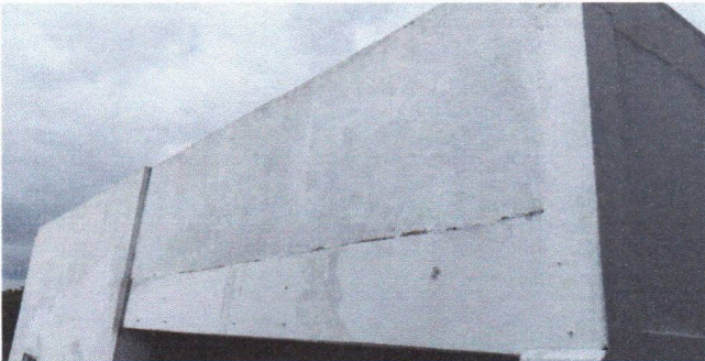
APLICAÇÃO DO SELADOR ACRÍLICO (ANEXO FUNDOS)
