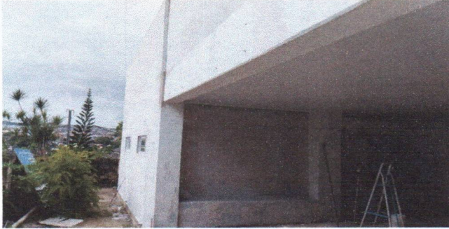
APLICAÇÃO DO SELADOR ACRÍLICO (ANEXO FUNDOS)
