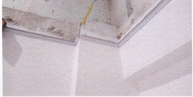
APLICAÇÃO DE PINTURA NAS PARDES (ANEXO FUNDOS)
