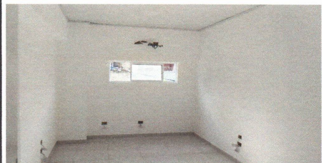
APLICAÇÃO DE PINTURA NAS PARDES (ANEXO FUNDOS)
