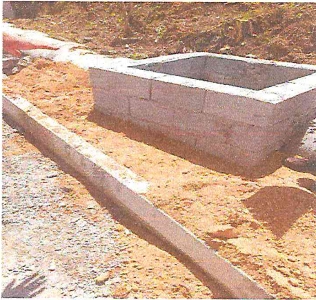
RUA ALAMEDA DAS PALMEIRAS (E0 à E18+12,00) - TIÚMA
