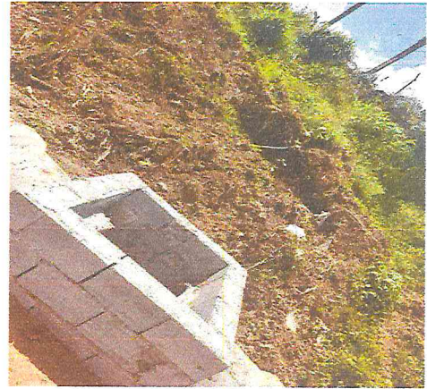
RUA ALAMEDA DAS PALMEIRAS (E0 à E18+12,00) - TIÚMA
