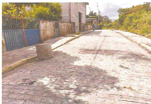
RUA ALAMEDA DAS PALMEIRAS (E0 à E10+4,70) - TIÚMA - E7
