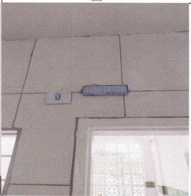
luminária de emergência
