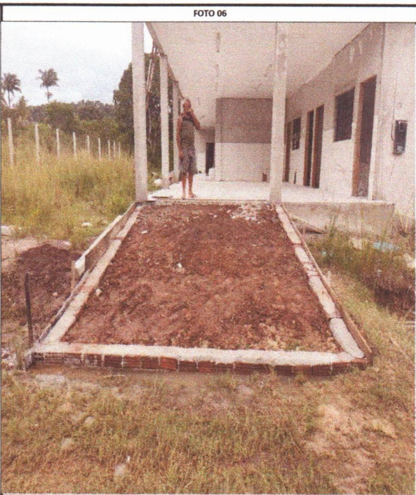
Reaterro manual apilado
