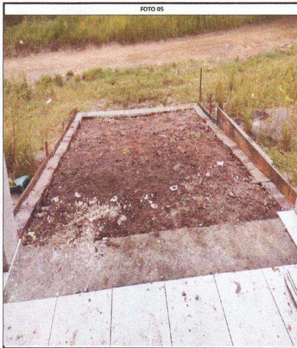
Reaterro manual apilado
