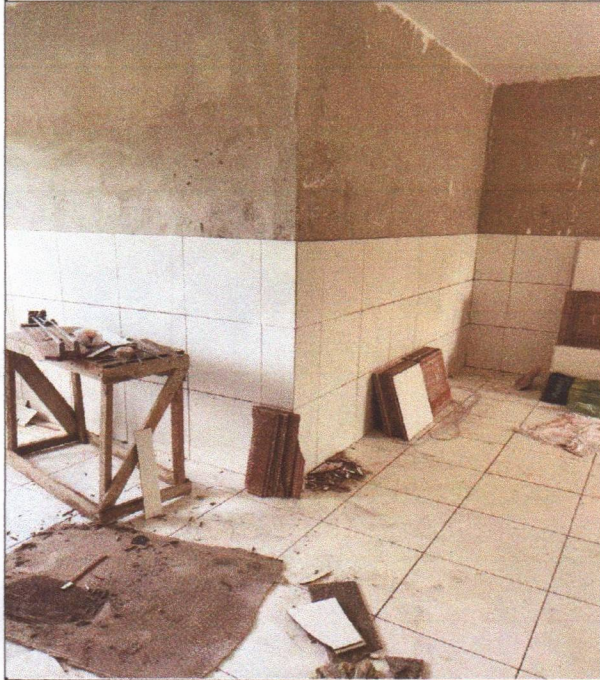
Assentamento de Cerâmica
