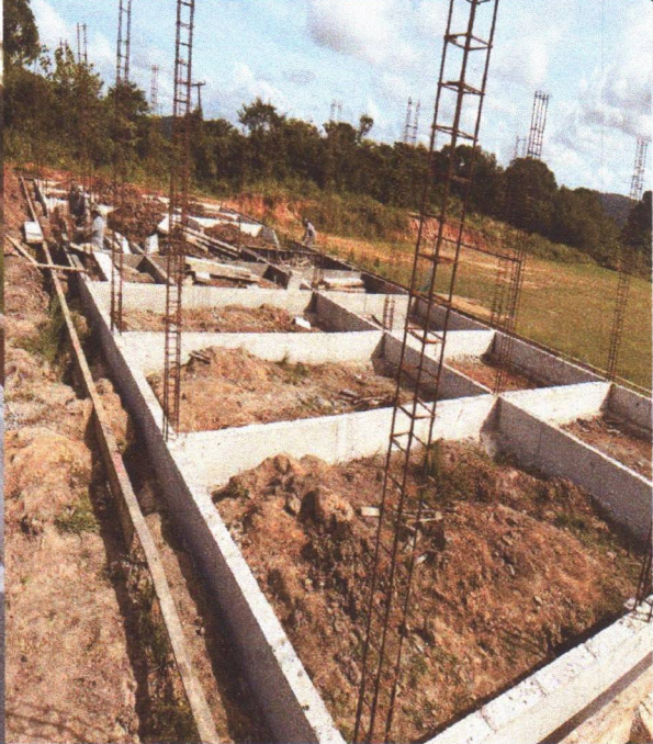
Reaterro manual apiloado
