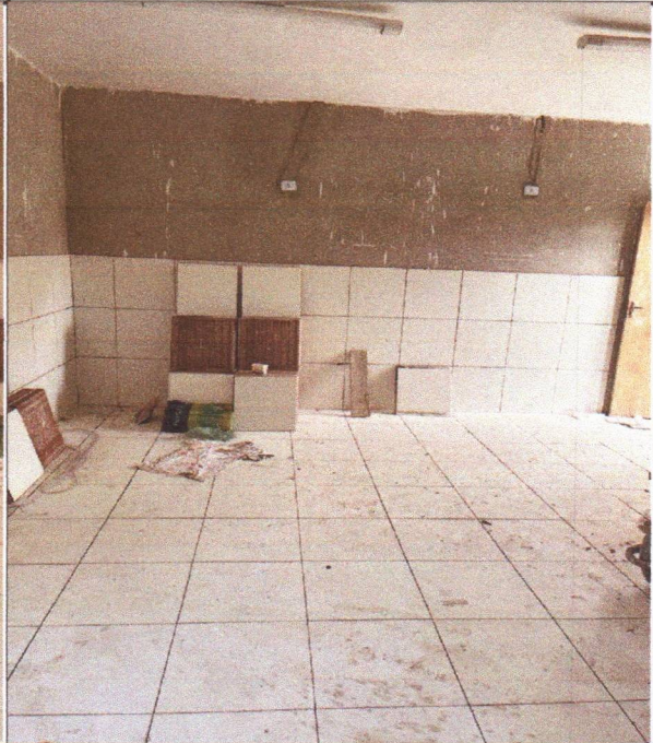
Assentamento de Cerâmica
