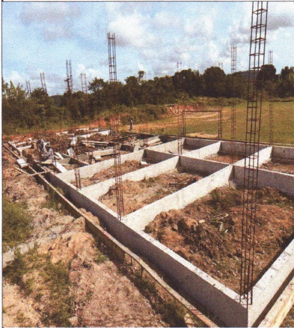
Reaterro manual apiloado
