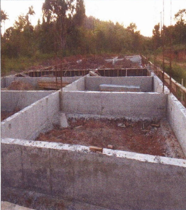
Reaterro manual apiloado
