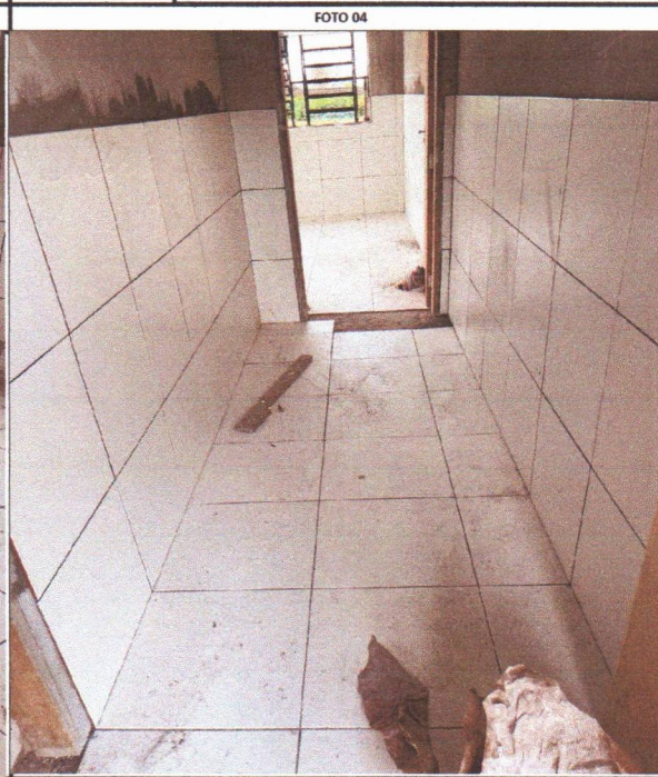
Assentamento de Cerâmica
