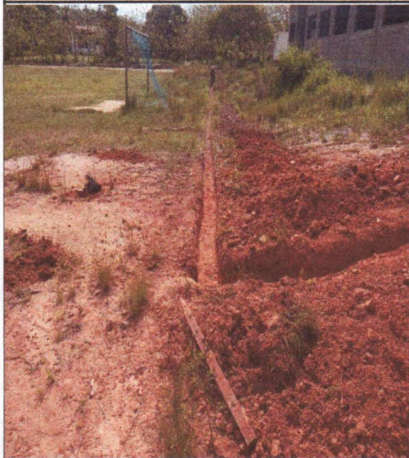
ESCAVAÇÃO E PREPARO DE FUNDO DE VALA
