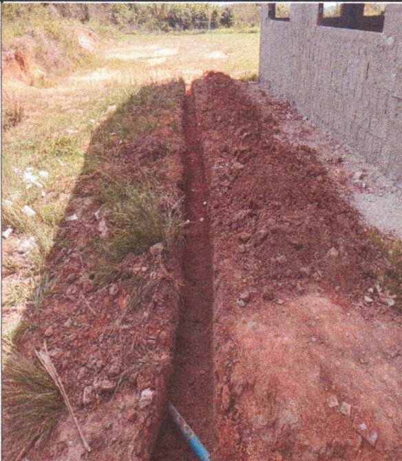
ESCAVAÇÃO E PREPARO DE FUNDO DE VALA
