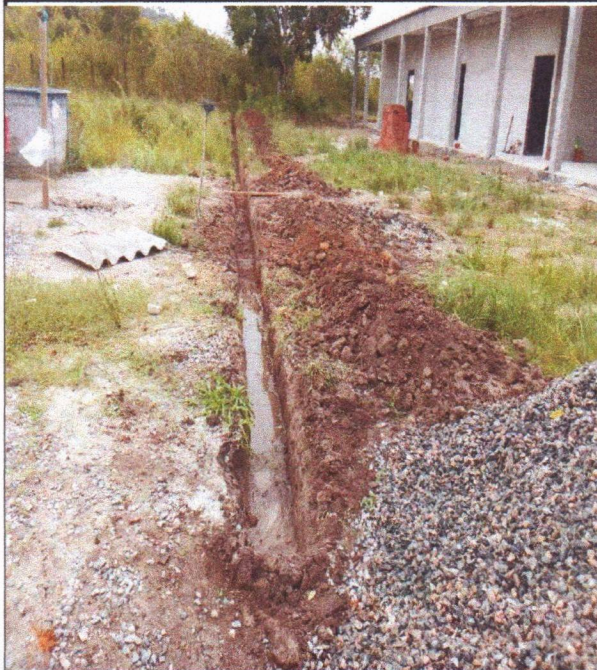
ESCAVAÇÃO E PREPARO DE FUNDO DE VALA
