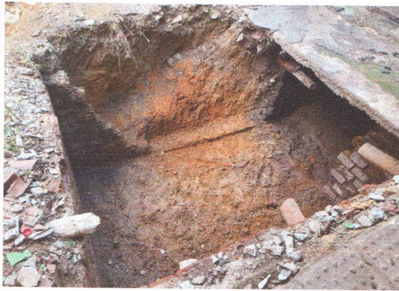
DEMOLIÇÃO DE ALVENARIA
