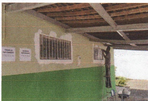
FORNECIMENTO E INSTALAÇÃO DAS JANELAS DE ALUMÍNIO
