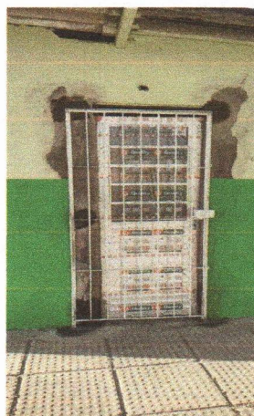
FORNECIMENTO E INSTALAÇÃO DA PORTA DE ALUMÍNIO
