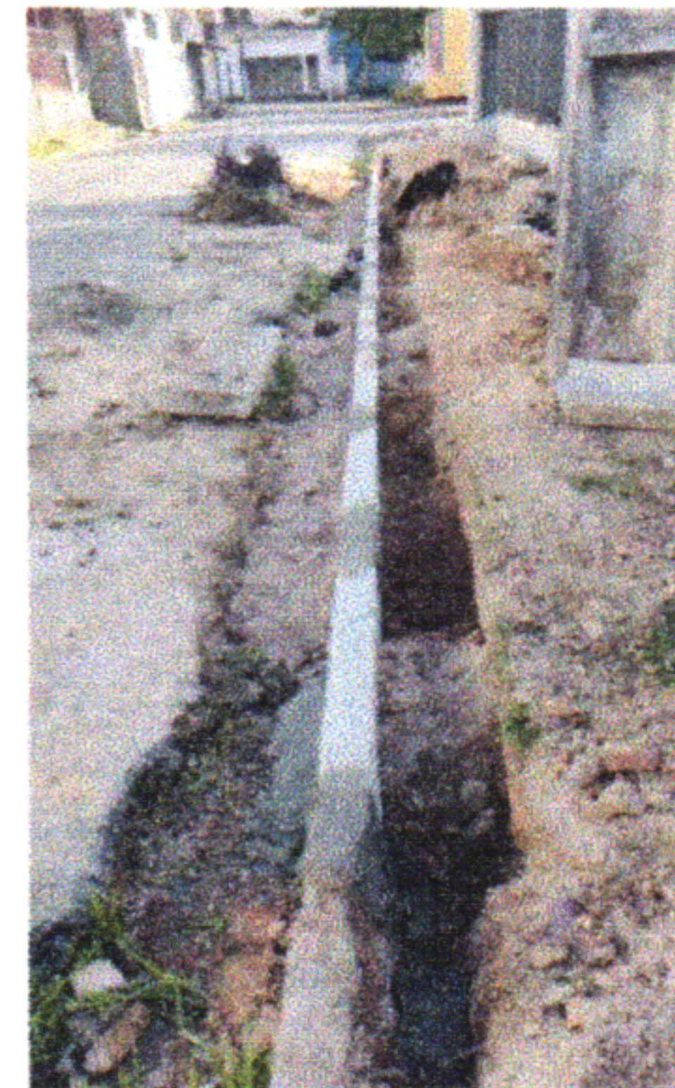
1.13.2 - ASSENTAMENTO DE MEIO FIO
