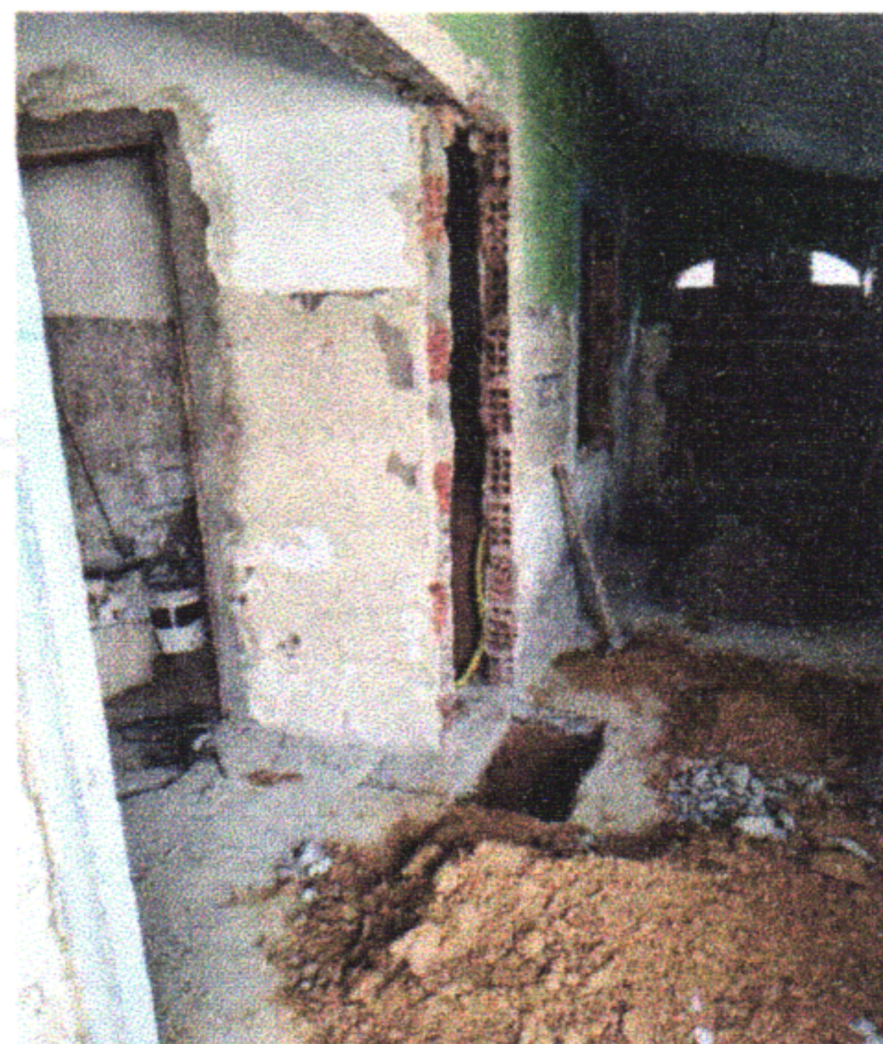
1.3.2 PREPARO DO FUNDO DE VALA
