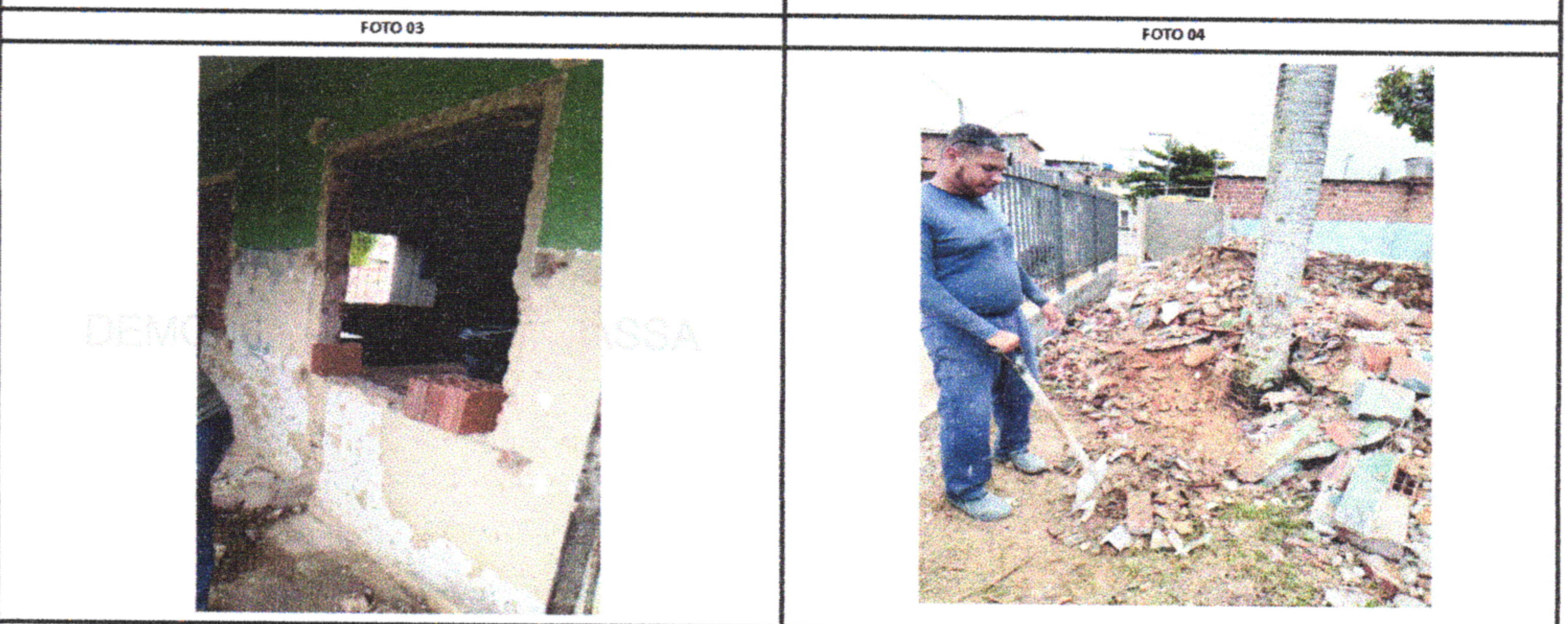
1.2.5 - REMOÇÃO DE JANELA
