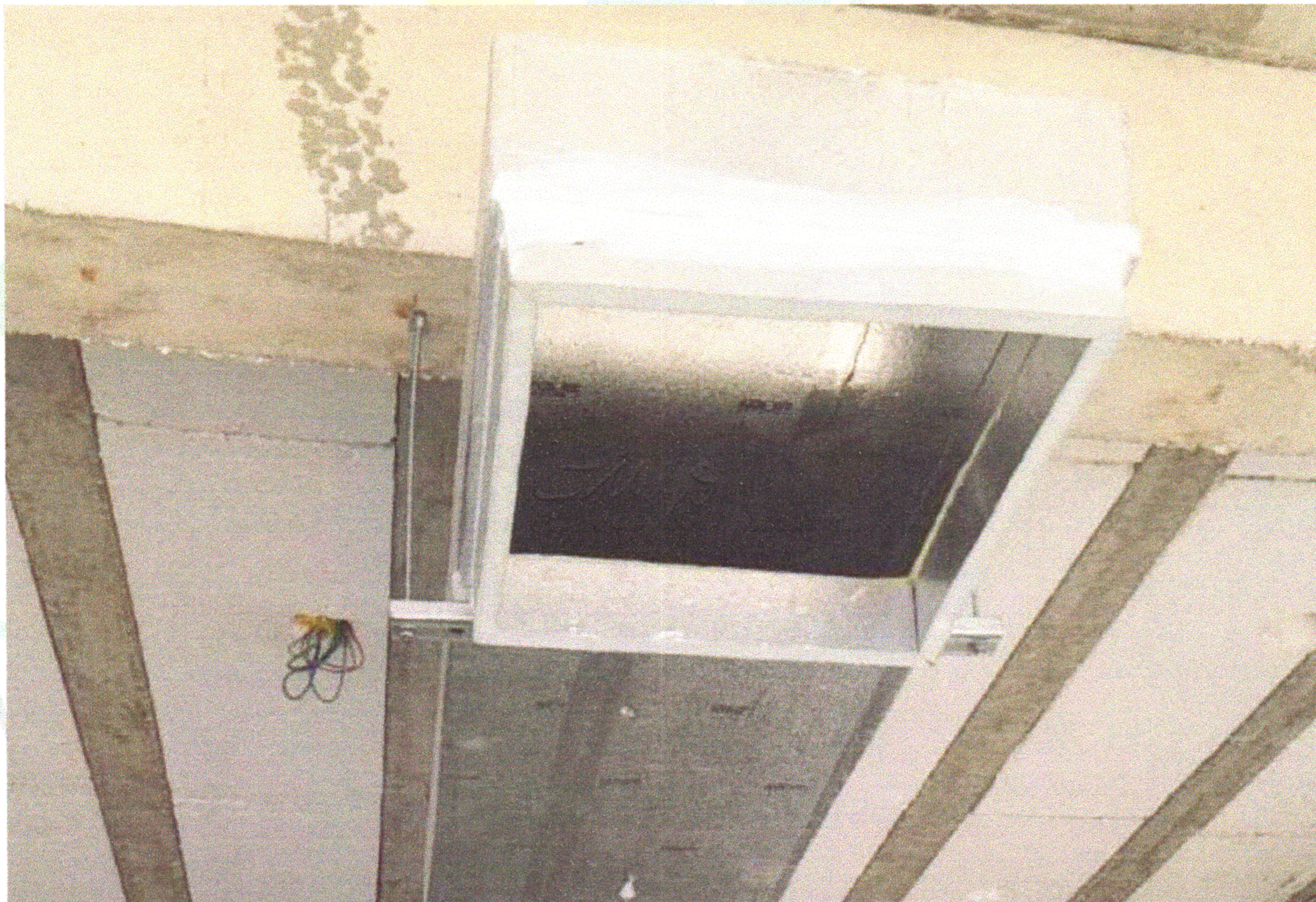
FOTO 03 (EXECUÇÃO DA REDE DE DUTOS PARA EXAUSTAO DE AR/VENTILACAO EM MPU)
