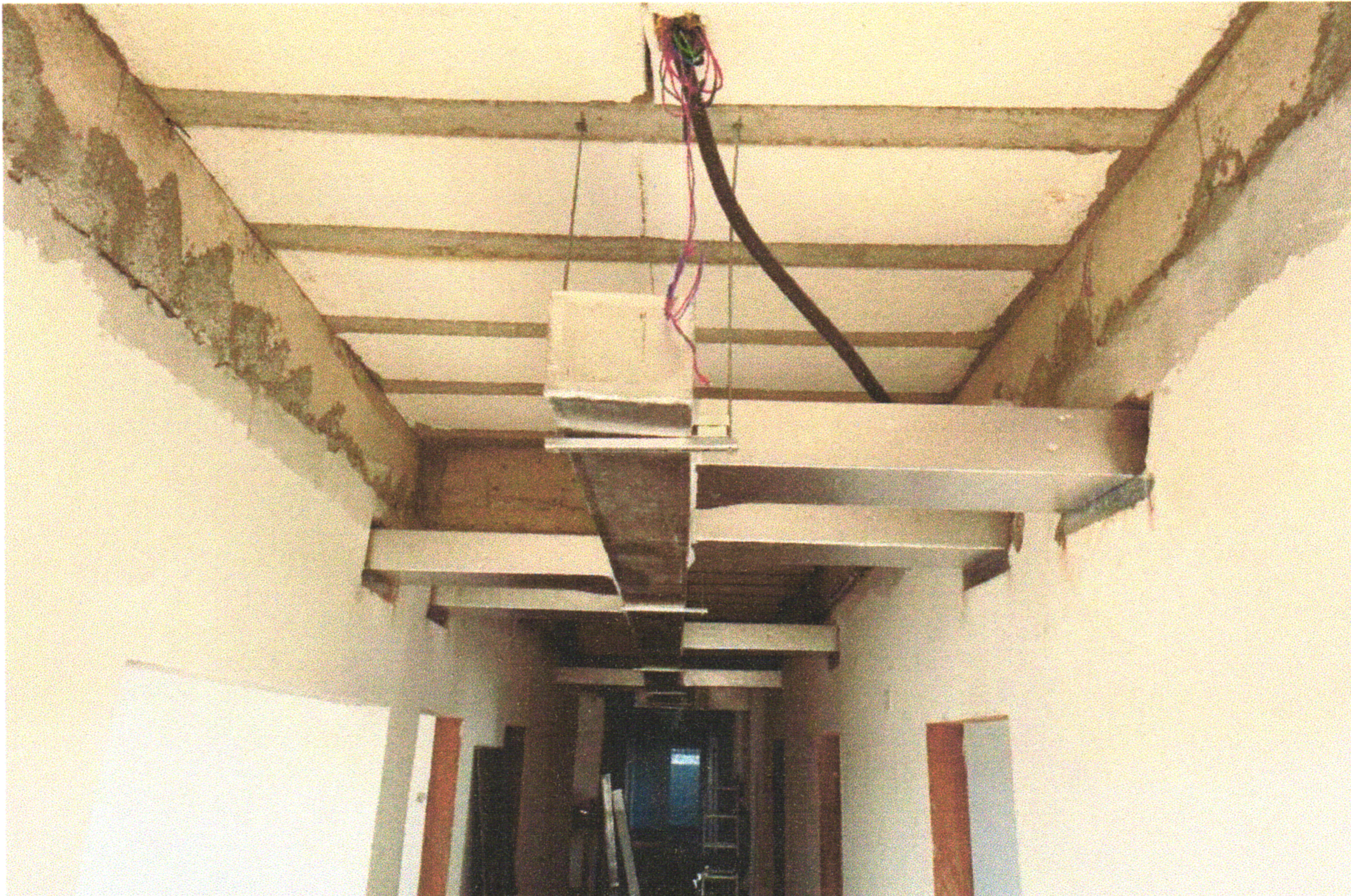
FOTO 02 (EXECUÇÃO DA REDE DE DUTOS PARA EXAUSTAO DE AR/VENTILACAO EM MPU)
