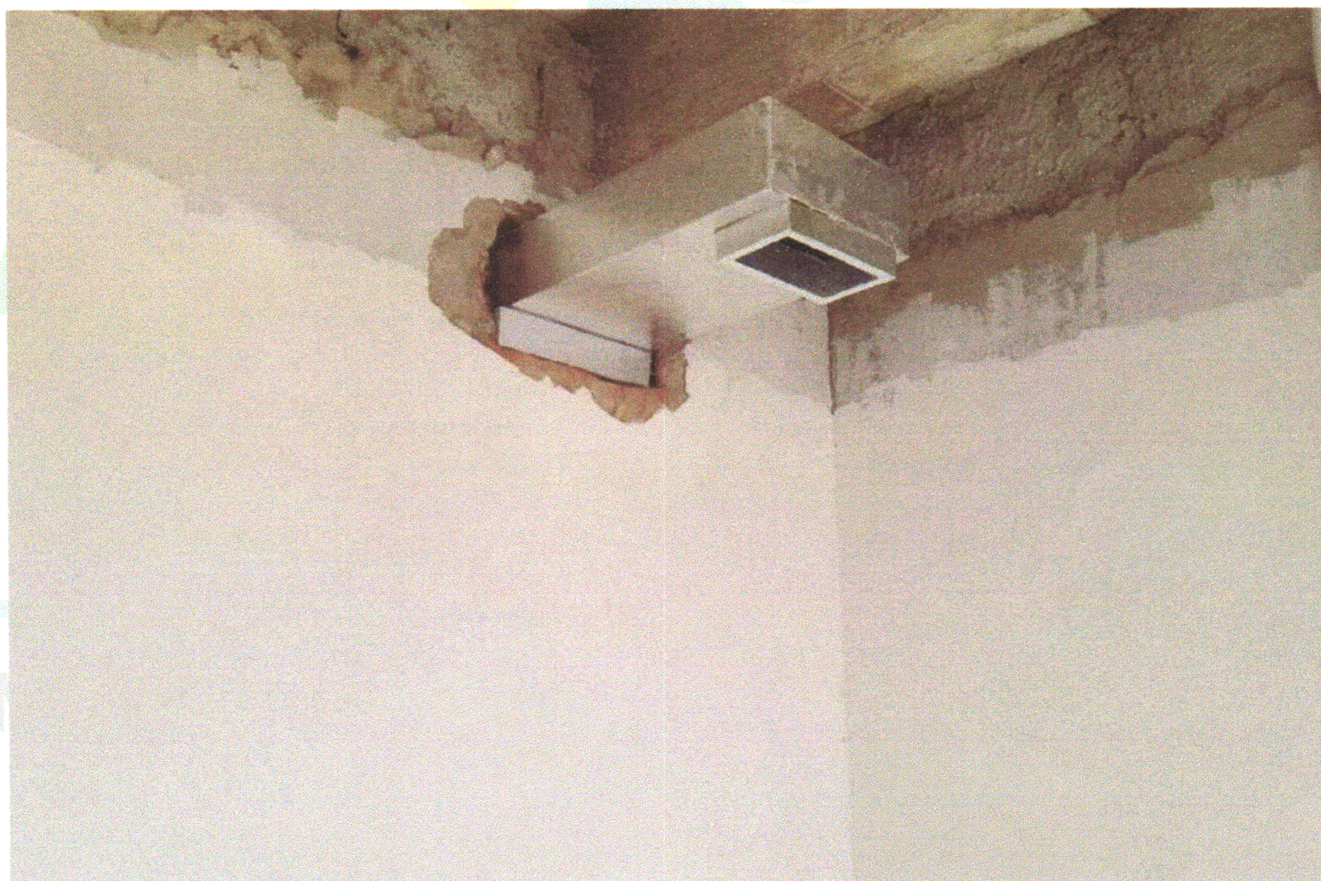
FOTO 07 (EXECUÇÃO DA REDE DE DUTOS PARA EXAUSTAO DE AR/VENTILACAO EM MPU)
