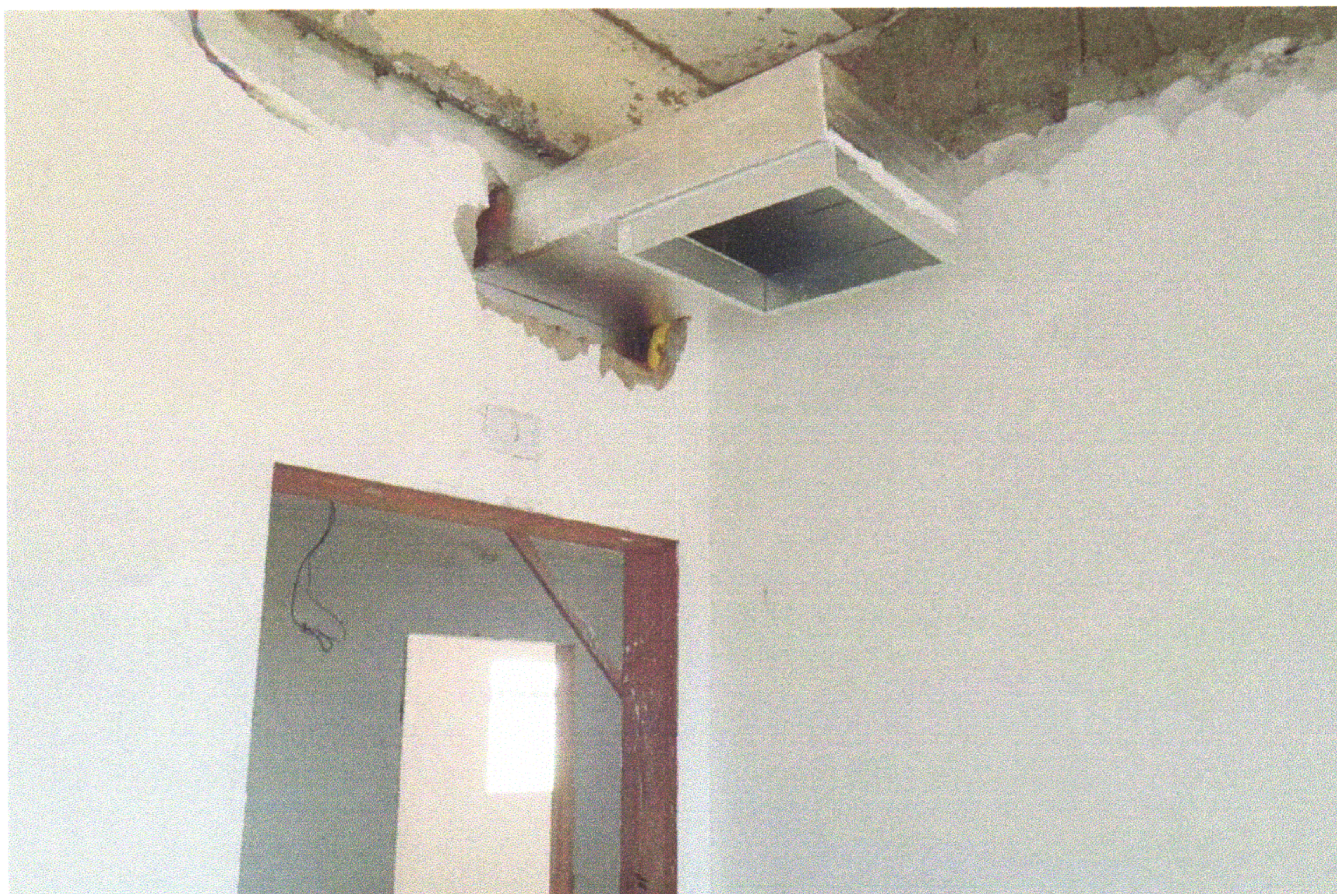
FOTO 06 (EXECUÇÃO DA REDE DE DUTOS PARA EXAUSTAO DE AR/VENTILACAO EM MPU)
