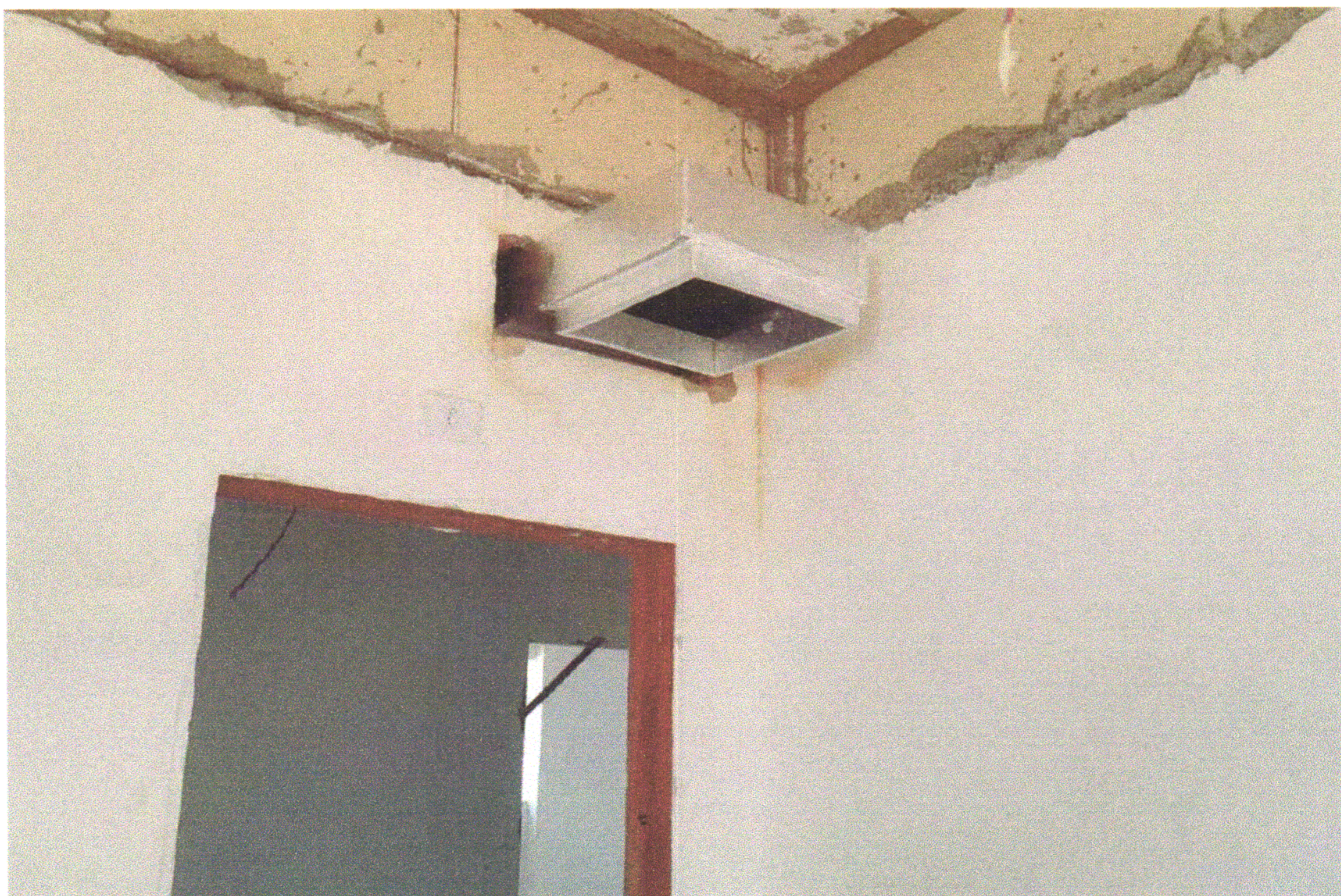
FOTO 08 (EXECUÇÃO DA REDE DE DUTOS PARA EXAUSTAO DE AR/VENTILACAO EM MPU)
