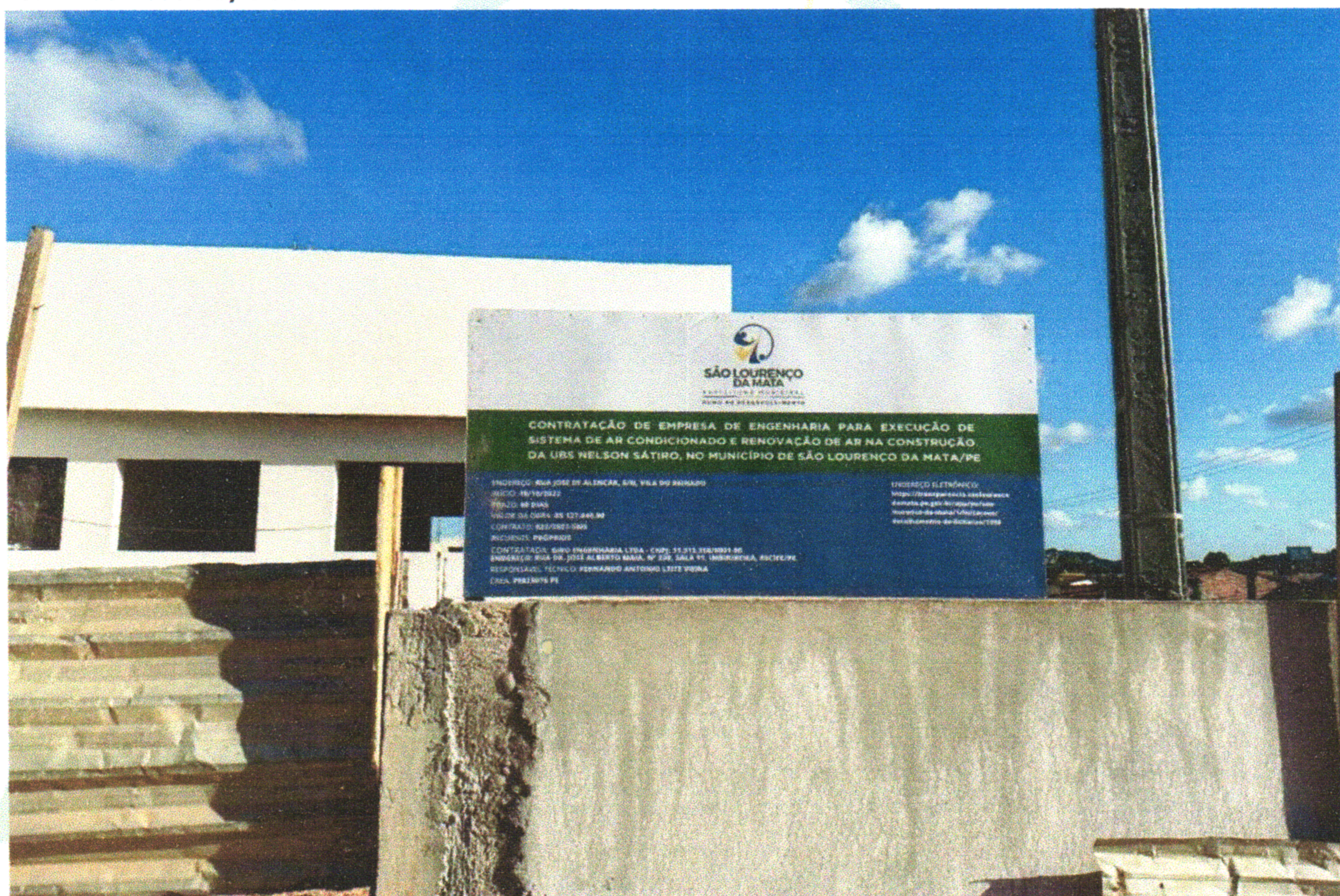
FOTO 01 (PLACA DE OBRA)
