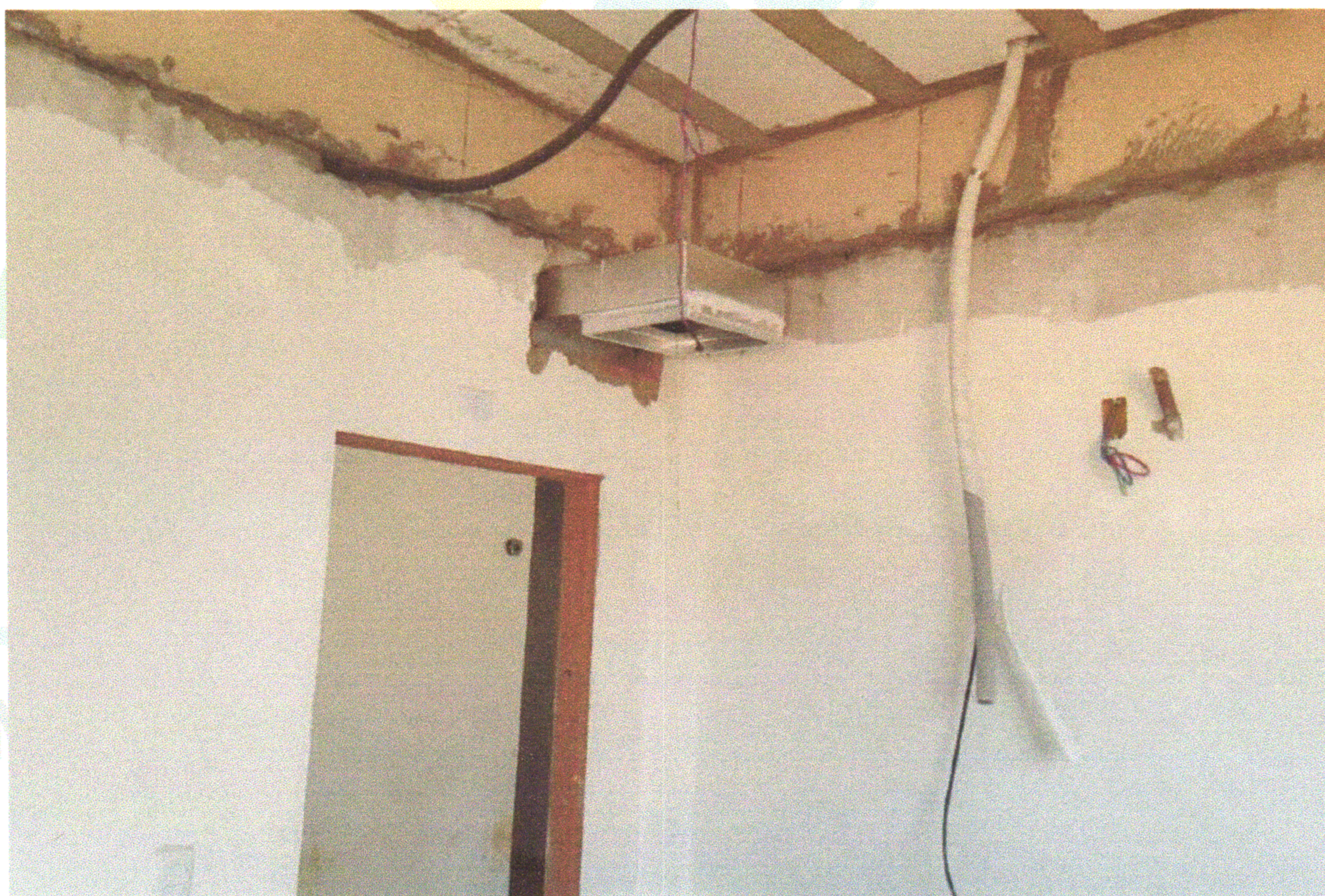
FOTO 09 (EXECUÇÃO DA REDE DE DUTOS PARA EXAUSTAO DE AR/VENTILACAO EM MPU)
