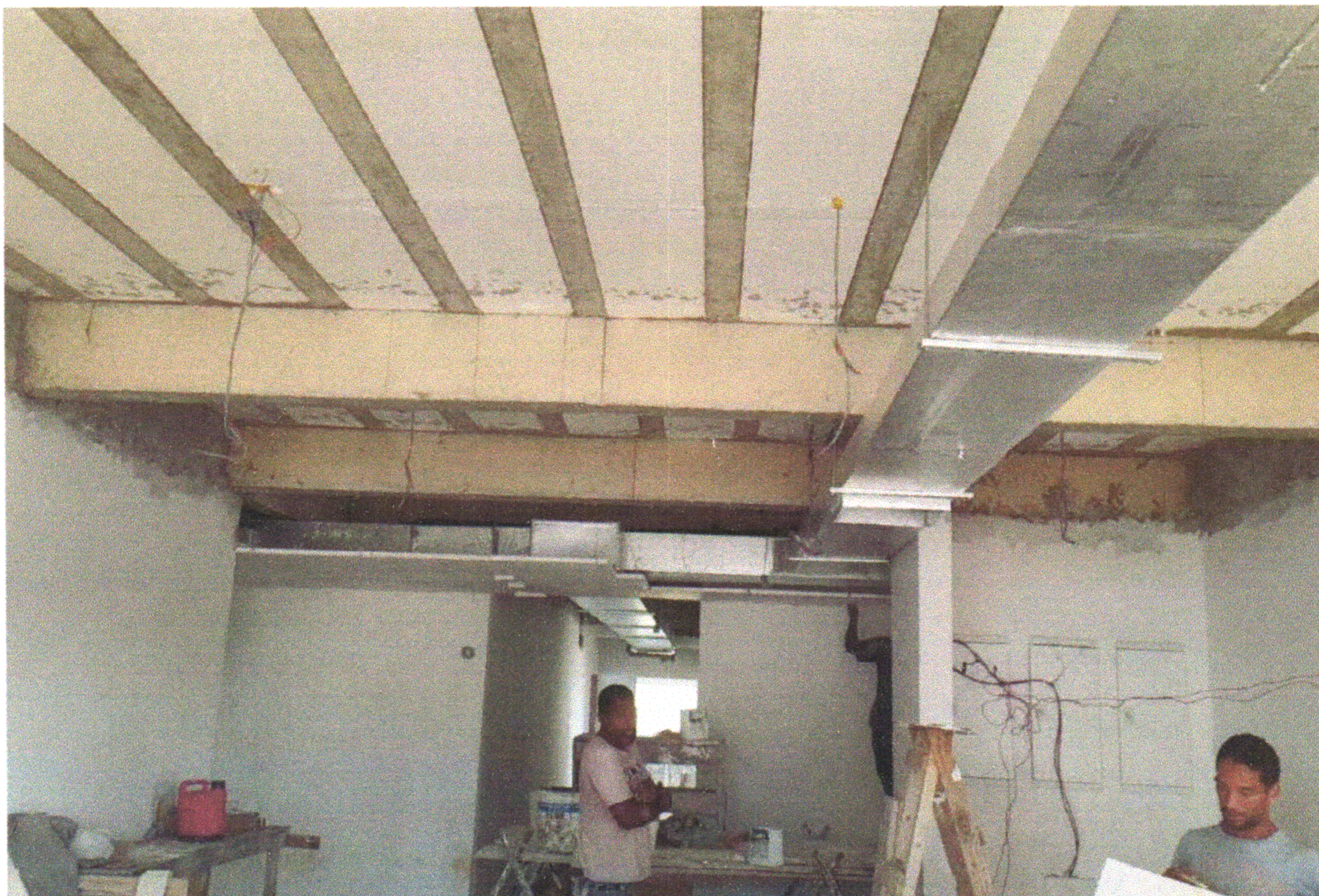
FOTO 10 (EXECUÇÃO DA REDE DE DUTOS PARA EXAUSTAO DE AR/VENTILACAO EM MPU)
