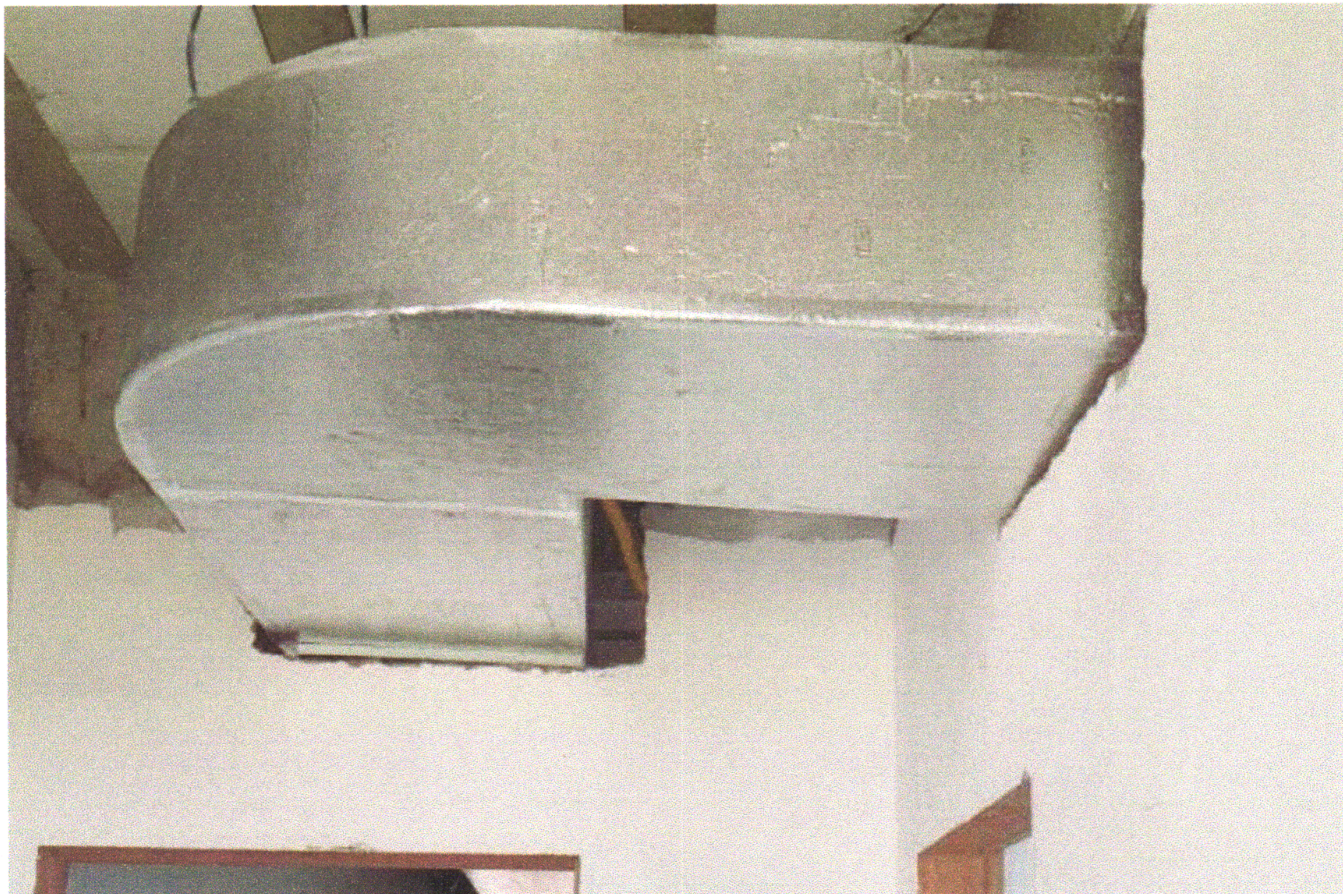
FOTO 04 (EXECUÇÃO DA REDE DE DUTOS PARA EXAUSTAO DE AR/VENTILACAO EM MPU)
