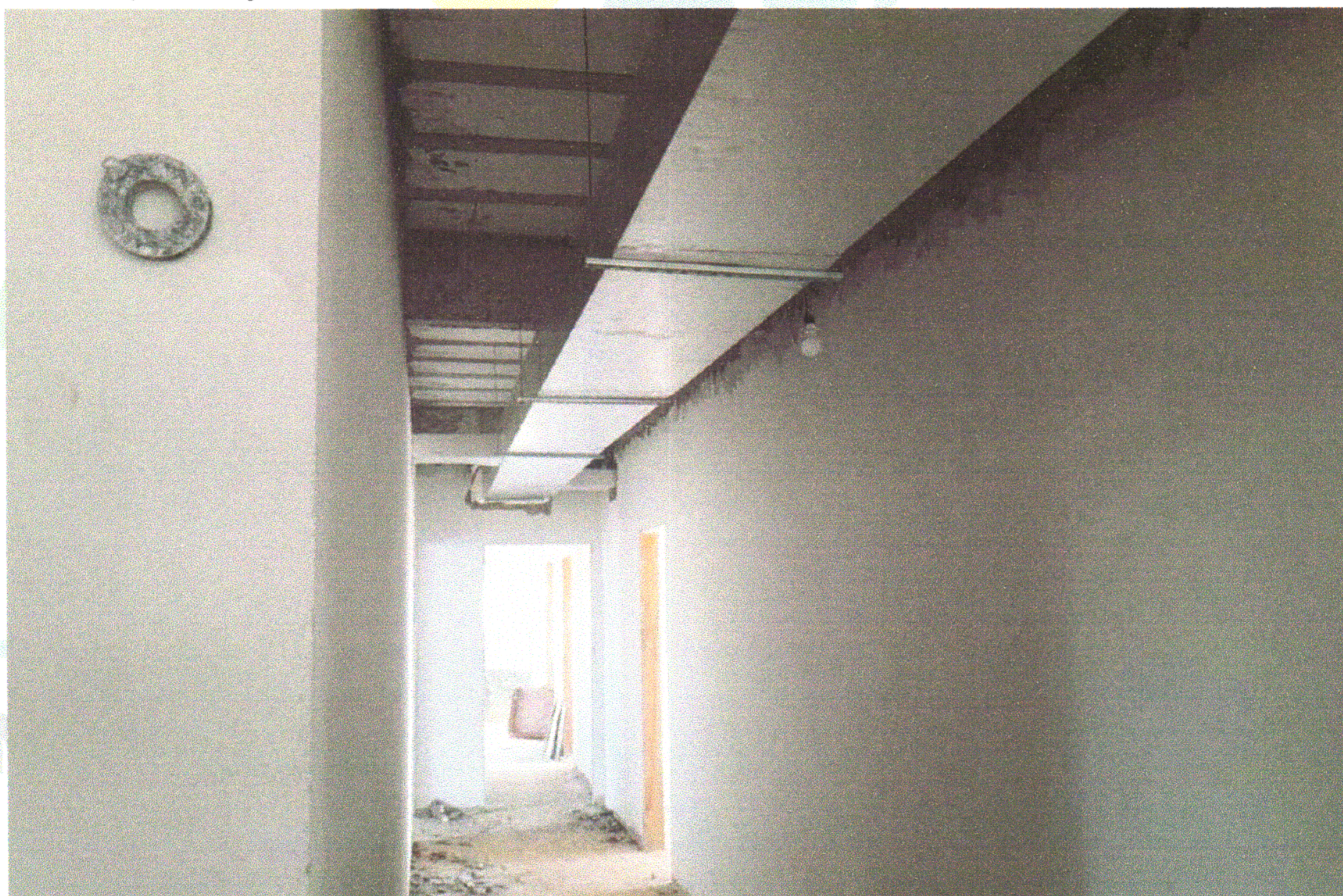
FOTO 11 (EXECUÇÃO DA REDE DE DUTOS PARA EXAUSTAO DE AR/VENTILACAO EM MPU)
