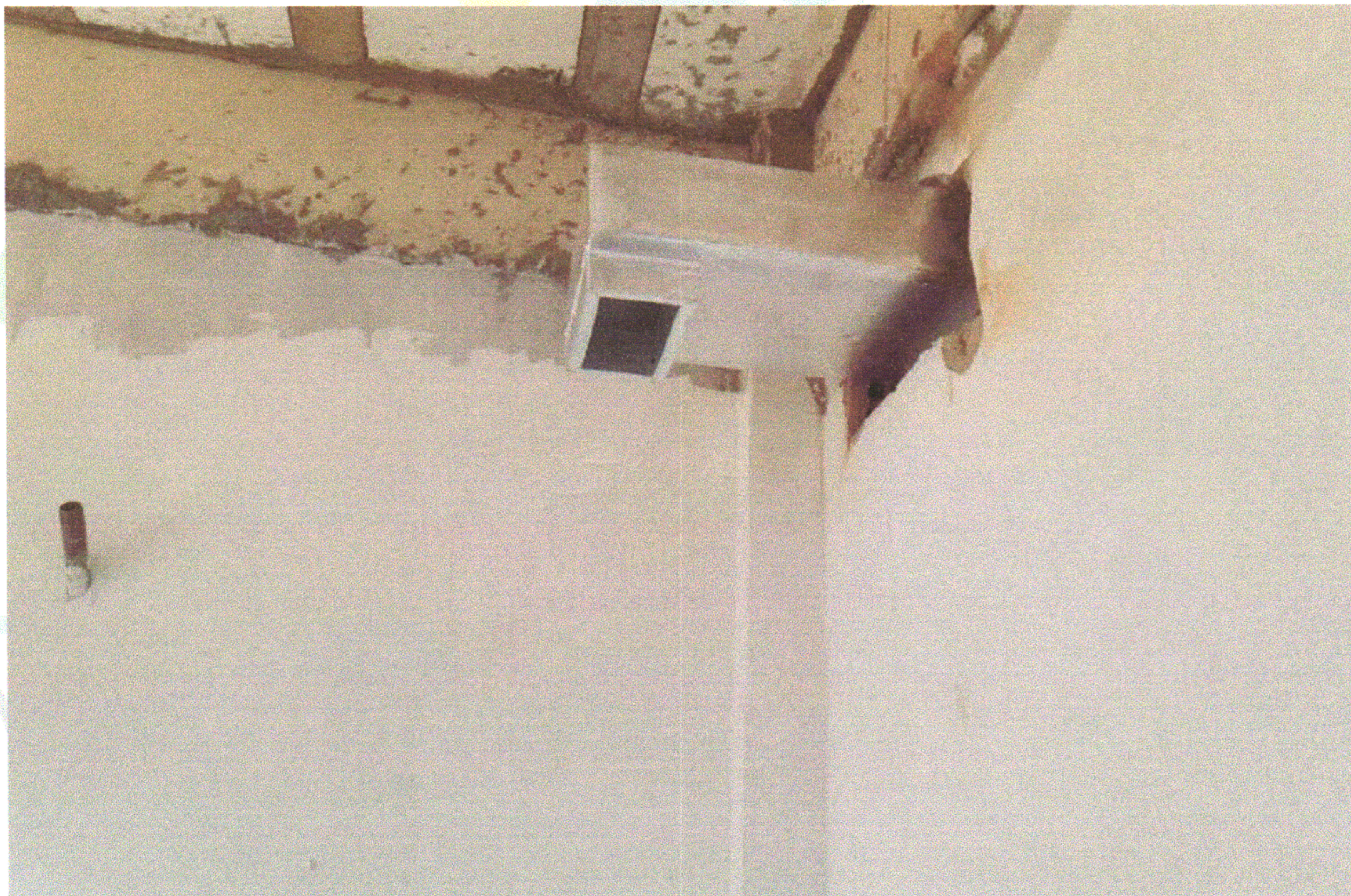
FOTO 05 (EXECUÇÃO DA REDE DE DUTOS PARA EXAUSTAO DE AR/VENTILACAO EM MPU)
