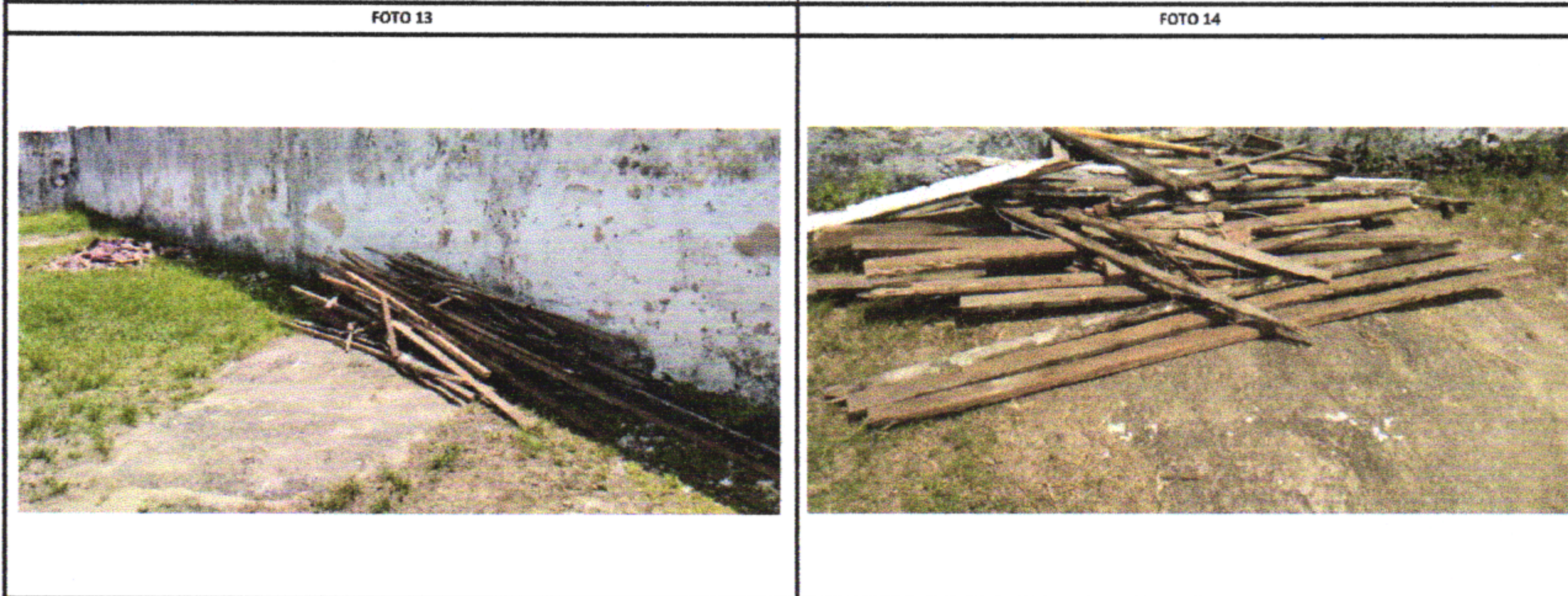
REMOÇÃO DE TRAMA DE MADEIRA REMOÇÃO DE TRAMA DE MADEIRA
