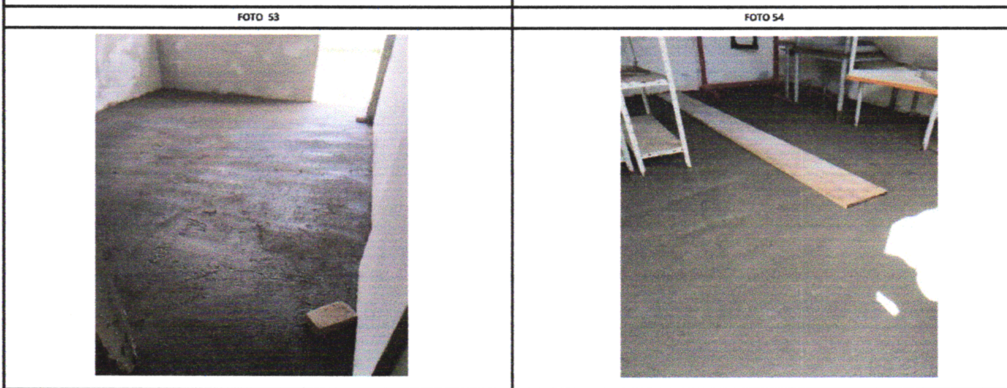
EXECUÇÃO DO PISO CIMENTADO EM TODOS OS AMBIENTES EXECUÇÃO DO PISO CIMENTADO EM TODOS OS AMBIENTES
