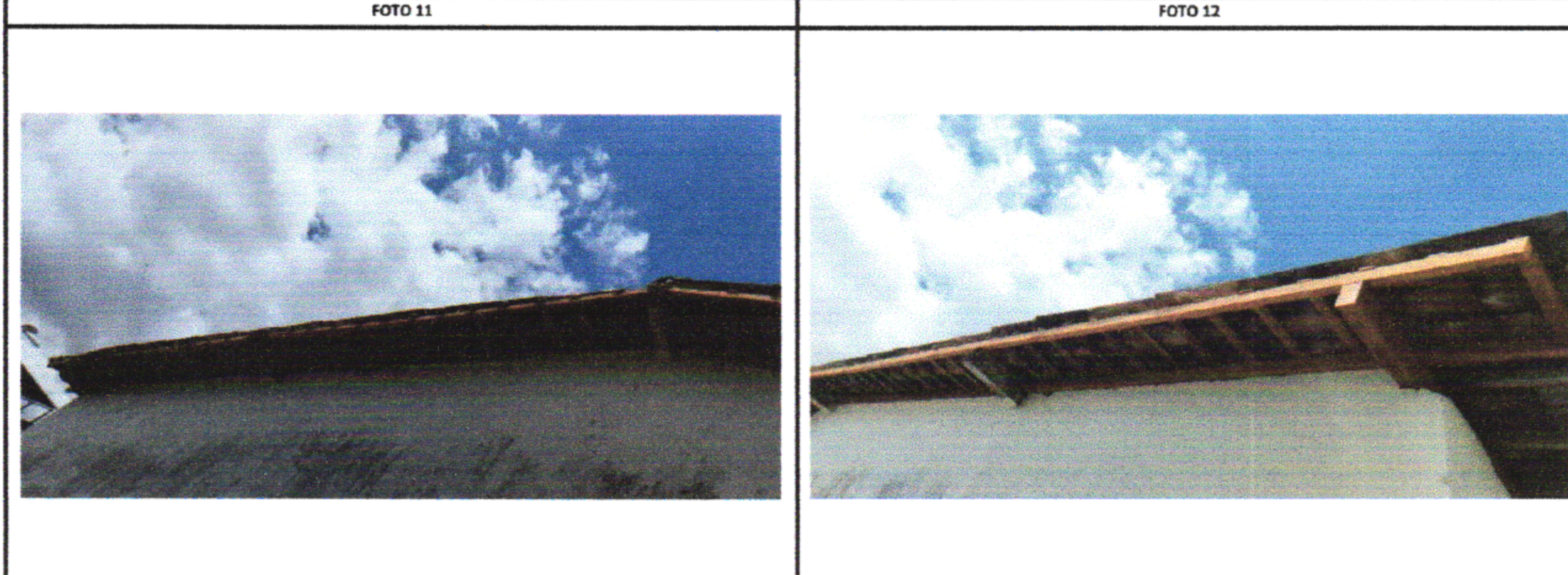
RETELHAMENTO E SUBSTITUIÇÃO DE TRAMA DE MADEIRA RETELHAMENTO E SUBSTITUIÇÃO DE TRAMA DE MADEIRA
