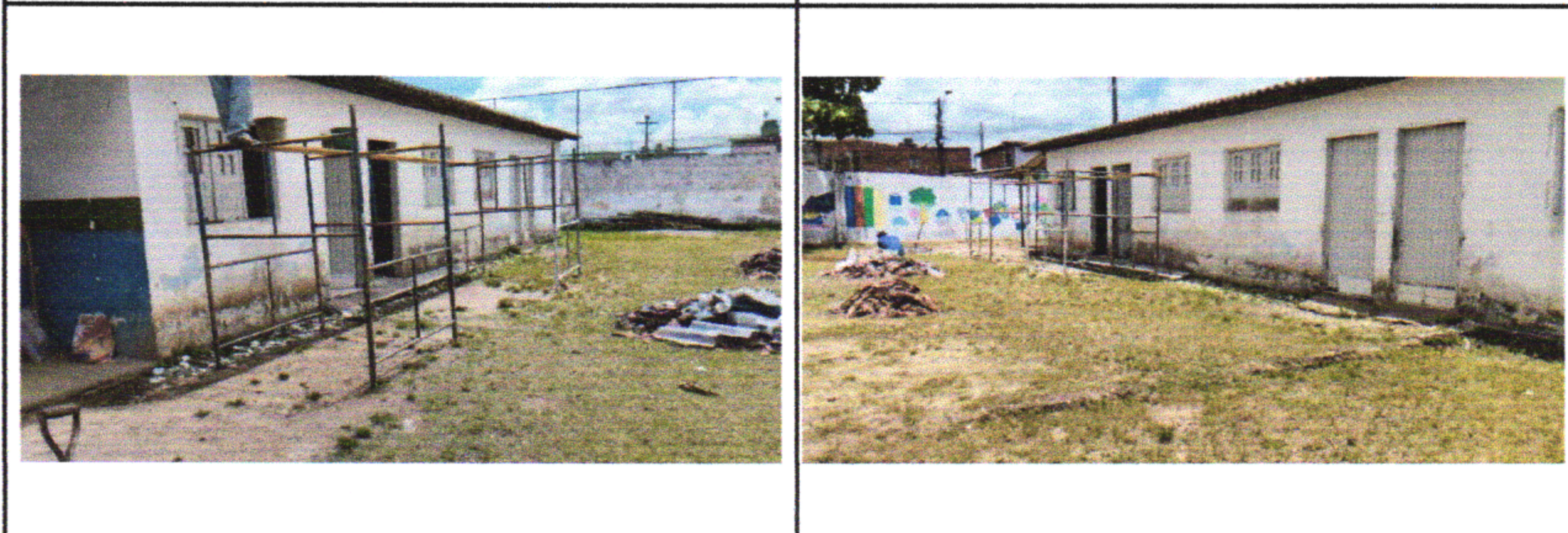
REMOÇÃO DE TELHAS CERÂMICAS TIPO COLONIAL, UTILIZAÇÃO DE ANDAIME PARA A EXECUÇÃO DO BEIRA E BICA REMOÇÃO DE TELHAS CERÂMICAS TIPO COLONIAL, UTILIZAÇÃO DE ANDAIME PARA A EXECUÇÃO DO BEIRA E BICA
