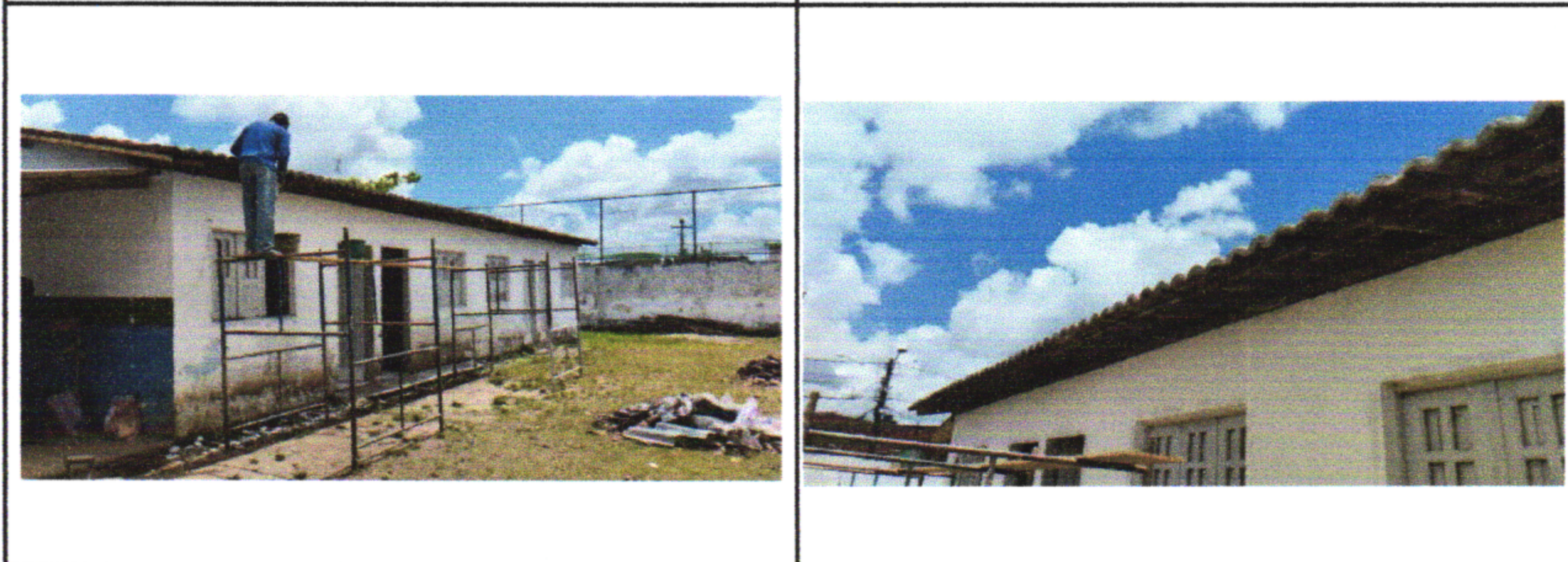
REMOÇÃO DE TELHAS CERÂMICAS TIPO COLONIAL, UTILIZAÇÃO DE ANDAIME PARA A EXECUÇÃO DO BEIRA E BICA REMOÇÃO DE TELHAS CERÂMICAS TIPO COLONIAL, UTILIZAÇÃO DE ANDAIME PARA A EXECUÇÃO DO BEIRA E BICA
