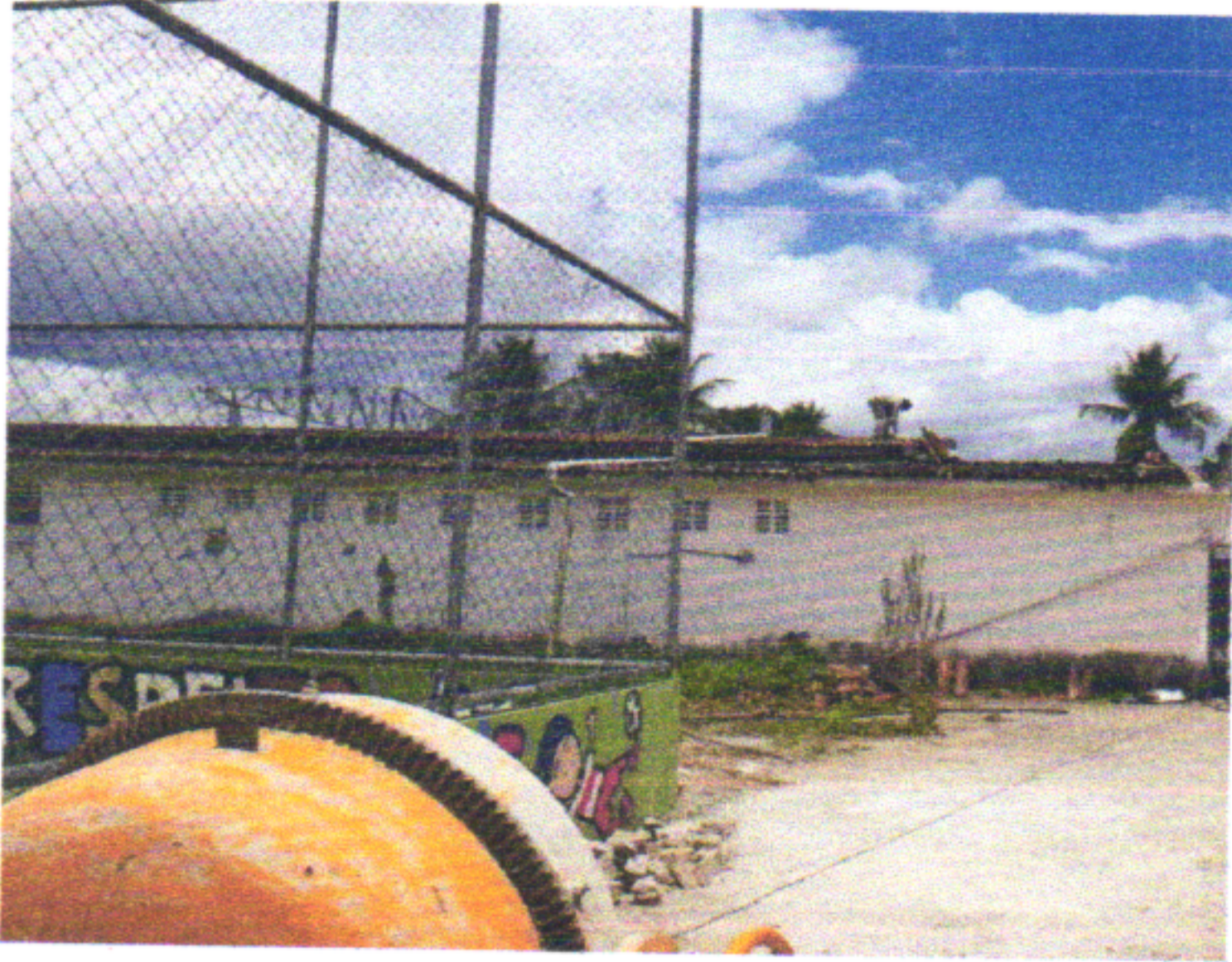
INÍCIO DOS SERVIÇOS DE RETELHAMENTO
