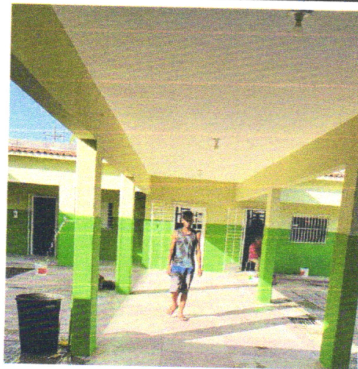
Conclusão dos serviços de pintura
