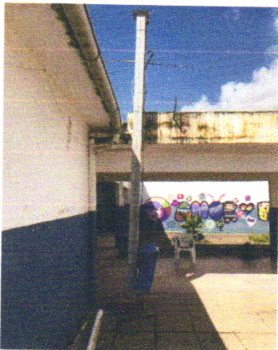
PÁTIO DA ESCOLA ANTES DE INICIAR OS SERVIÇOS DE PINTURA
