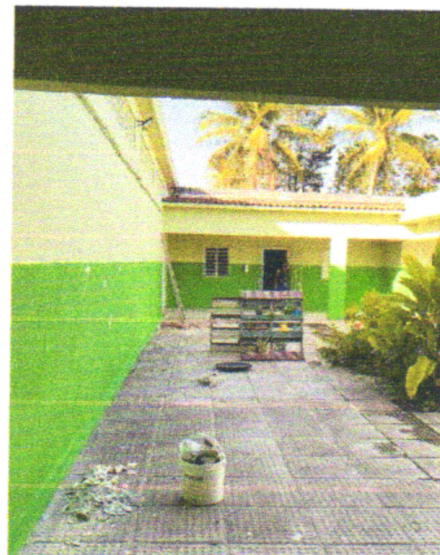
SERVIÇOS DE PINTURA EM ANDAMENTO
