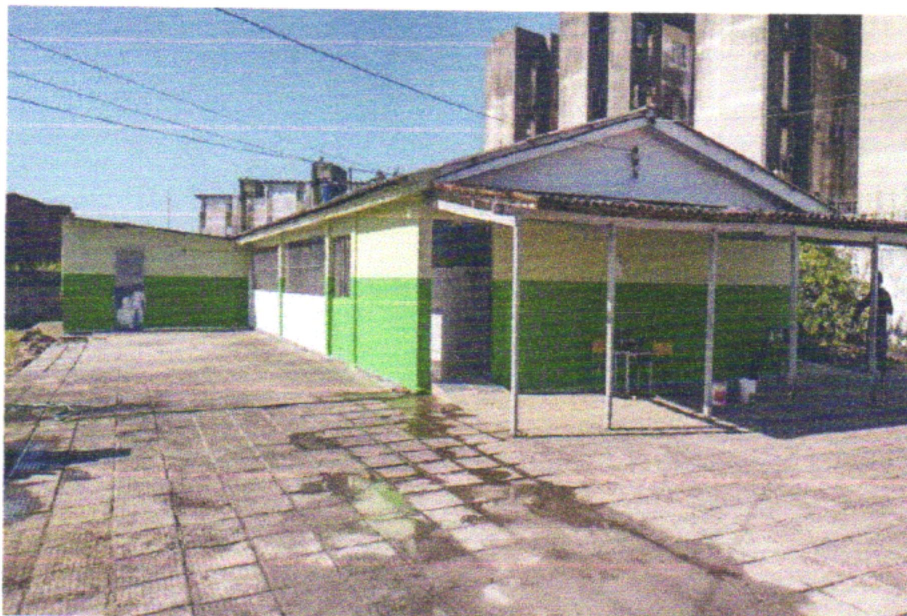
APLICAÇÃO DE PINTURA NA FACHADA
