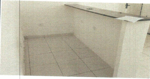
ELEVAÇÃO EM BLOCO DE GESSO, EMASSAMENTO COM MASSA CORRIDA, COM ASSENTAMENTO DA BANCADA EM GRANITO, INSTALAÇÃO DE TOMADAS DE SOBREPOR E DE EMBUTIR NA RECEPÇÃO
