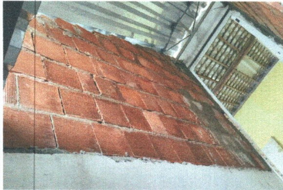
ELEVAÇÃO EM ALVENARIA DE VEDAÇÃO NA ÁREA DA ESCADA
