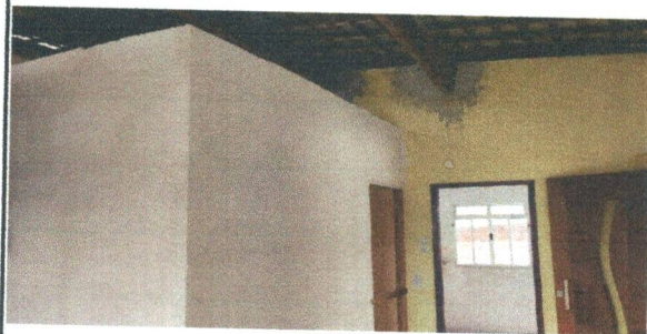
DIVISÓRIAS COM ELEVAÇÃO EM BLOCO DE GESSO, EMASSAMENTO COM MASSA CORRIDA E COM INSTALAÇÃO DE KIT DE PORTA
