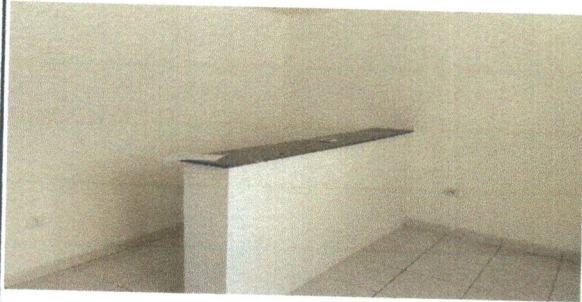
ELEVAÇÃO EM BLOCO DE GESSO, EMASSAMENTO COM MASSA CORRIDA, COM ASSENTAMENTO DA BANCADA EM GRANITO, INSTALAÇÃO DE TOMADAS DE SOBREPOR E DE EMBUTIR NA RECEPÇÃO
