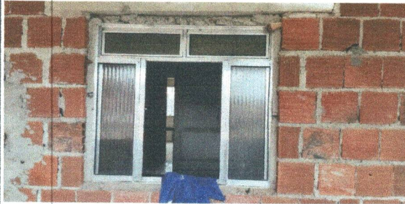
INSTALAÇÃO / COLOCAÇÃO DO VIDRO NA JANELA
