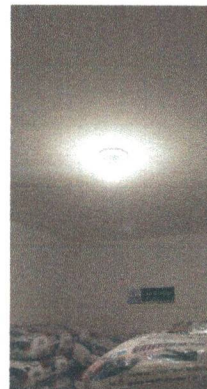
INSTALAÇÃO DE LUMINÁRIA PLAFON DE SOBREPOR COM LÂMPADA LED
