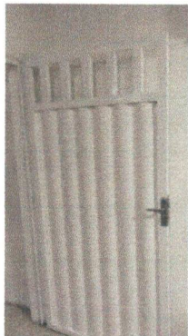
PINTURA ESMALTE DO PORTÃO QUE DA ACESSO A ESCADA
