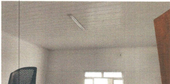
APLICAÇÃO DO FORRO EM RÉGUAS DE PVC, APLICAÇÃO DE PINTURA ACRÍLICA NAS PAREDES E INSTALAÇÃO DO KIT DE PROTEÇÃO ARSTOP PARA AR CONDICIONADO
