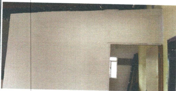
DIVISÓRIAS COM ELEVAÇÃO EM BLOCO DE GESSO, EMASSAMENTO COM MASSA CORRIDA E COM INSTALAÇÃO DE KIT DE PORTA
