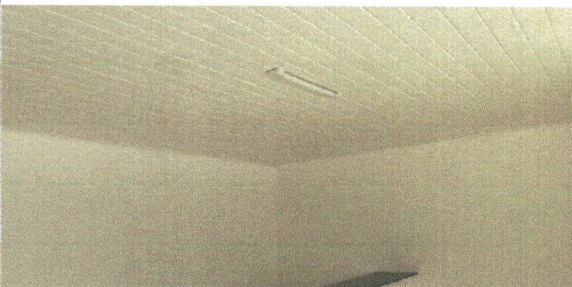
APLICAÇÃO DO FORRO EM RÉGUAS DE PVC E APLICAÇÃO DE PINTURA ACRÍLICA NAS PAREDES
