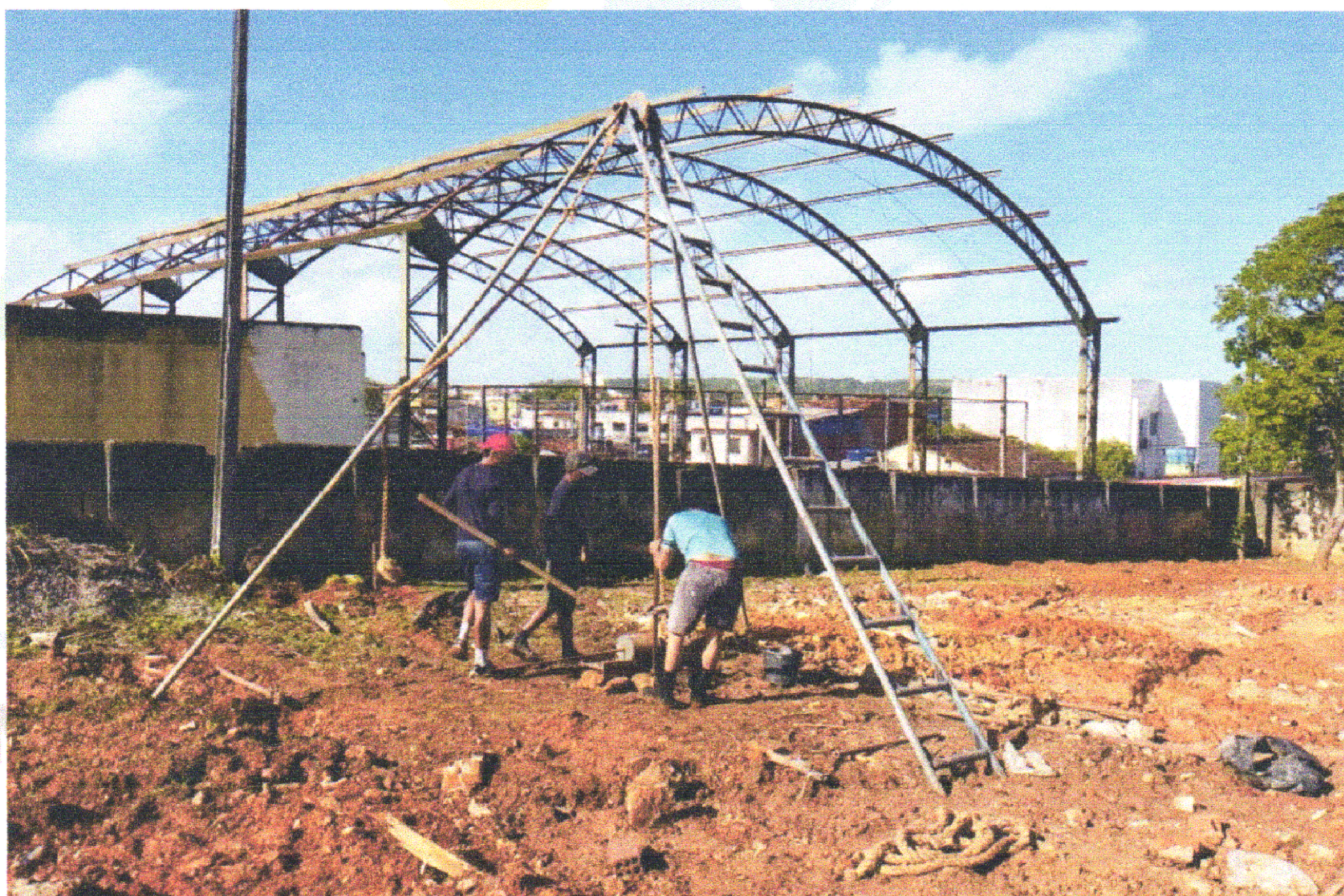
FOTO 03 (SONDAGEM DO TERRENO)
