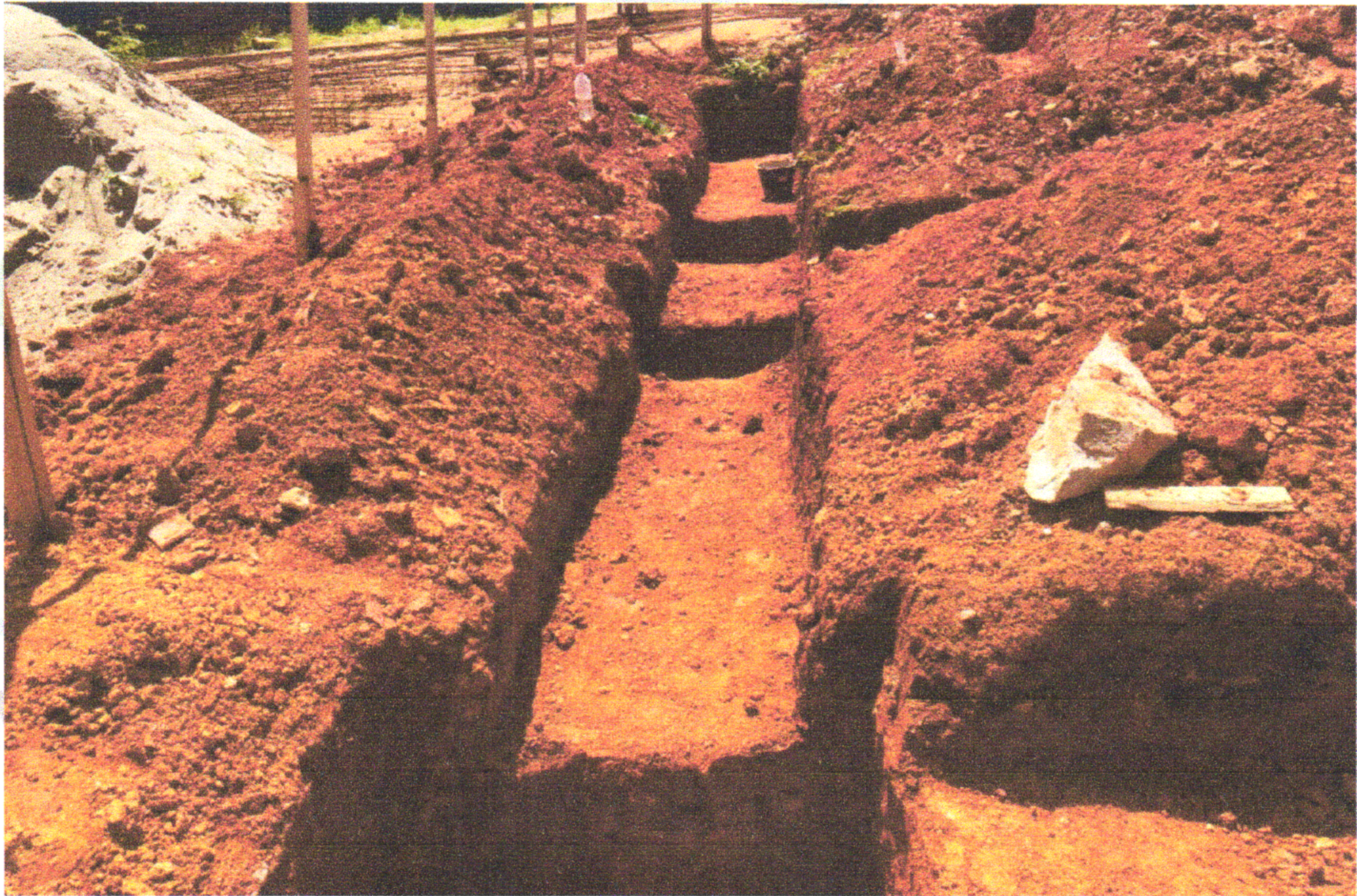
FOTO 09 (ESCAVAÇÃO VIGA BALDRAME E PRAPARO DE FUNDO DE VALA)
