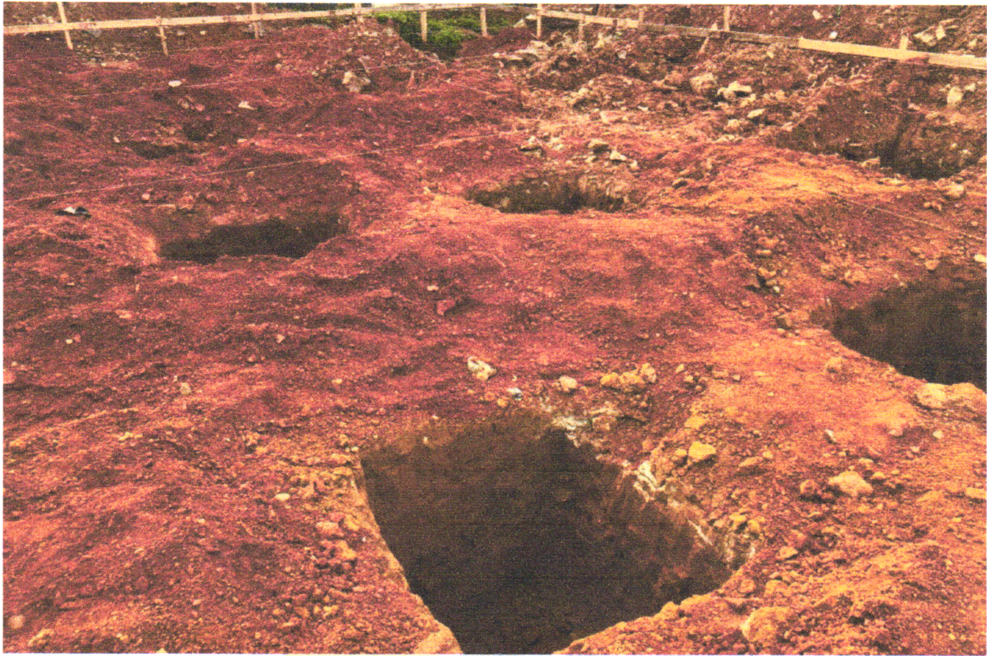
FOTO 08 (ESCAVAÇÃO DAS SAPATAS)
