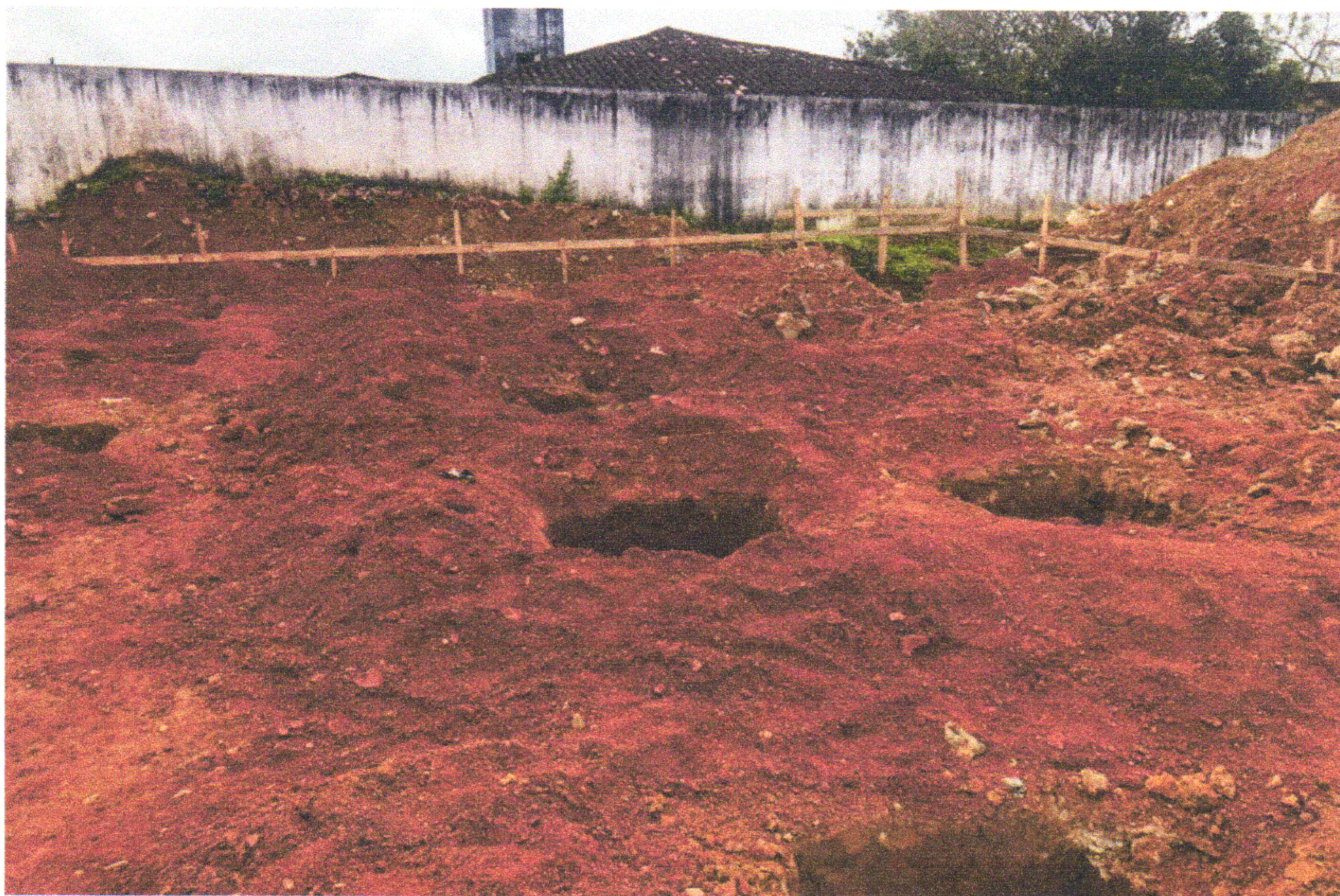
FOTO 06 (LOCAÇÃO DE OBRA E ESCAVAÇÃO DAS SAPATAS)
