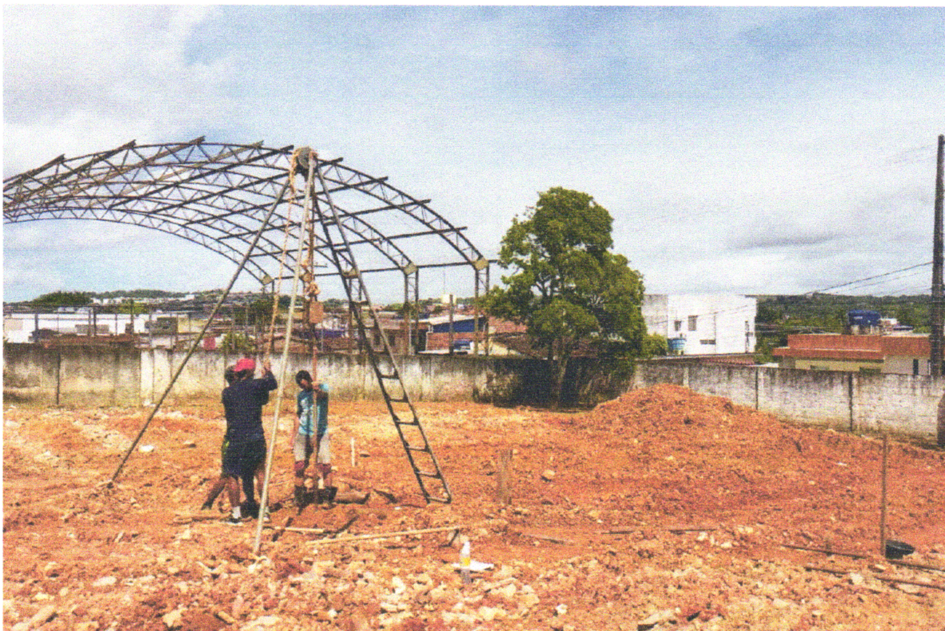
FOTO 02 (SONDAGEM DO TERRENO)
