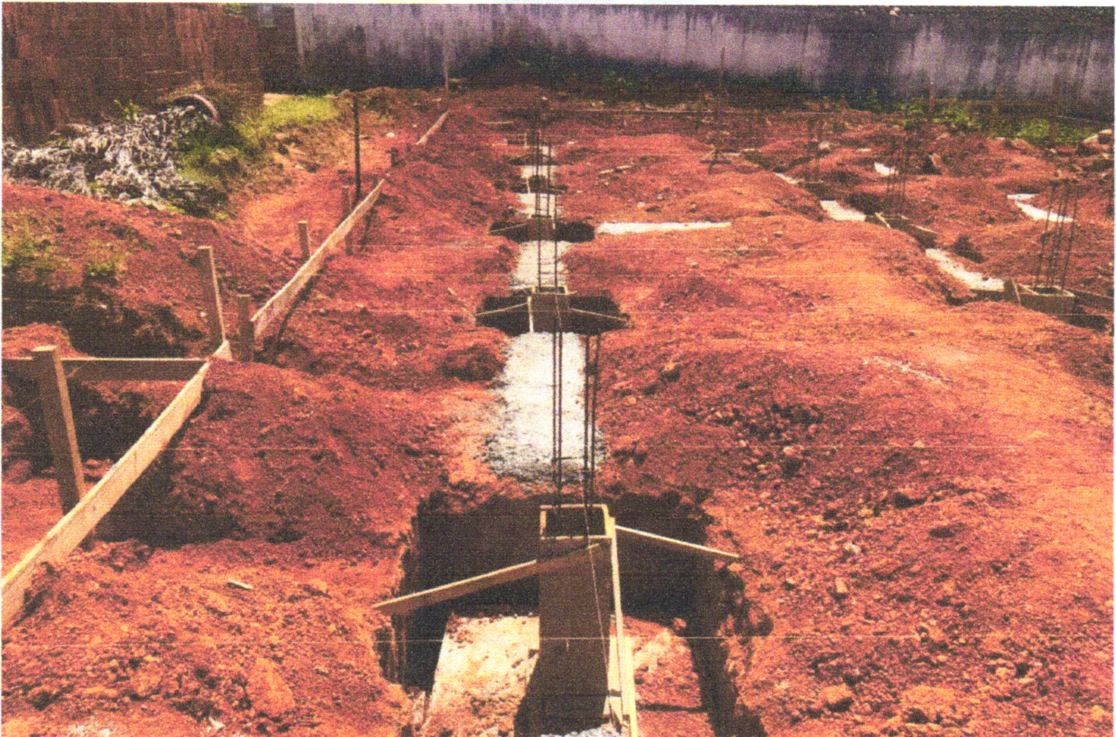
FOTO 13 (LASTRO DE CONCRETO)
