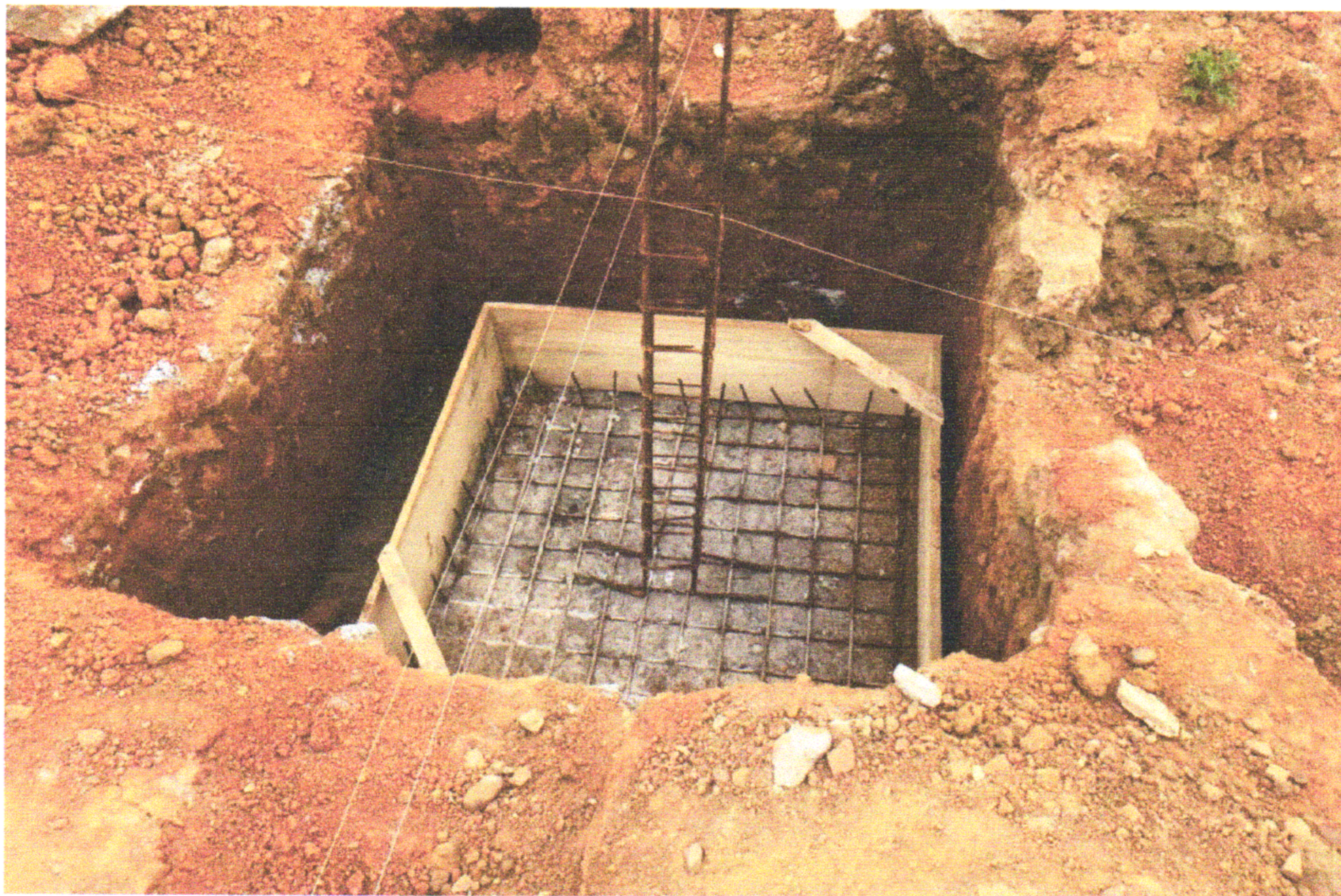
FOTO 10 (ARMAÇÃO E FÔRMA DAS SAPATAS E LASTRO DE CONCRETO)
