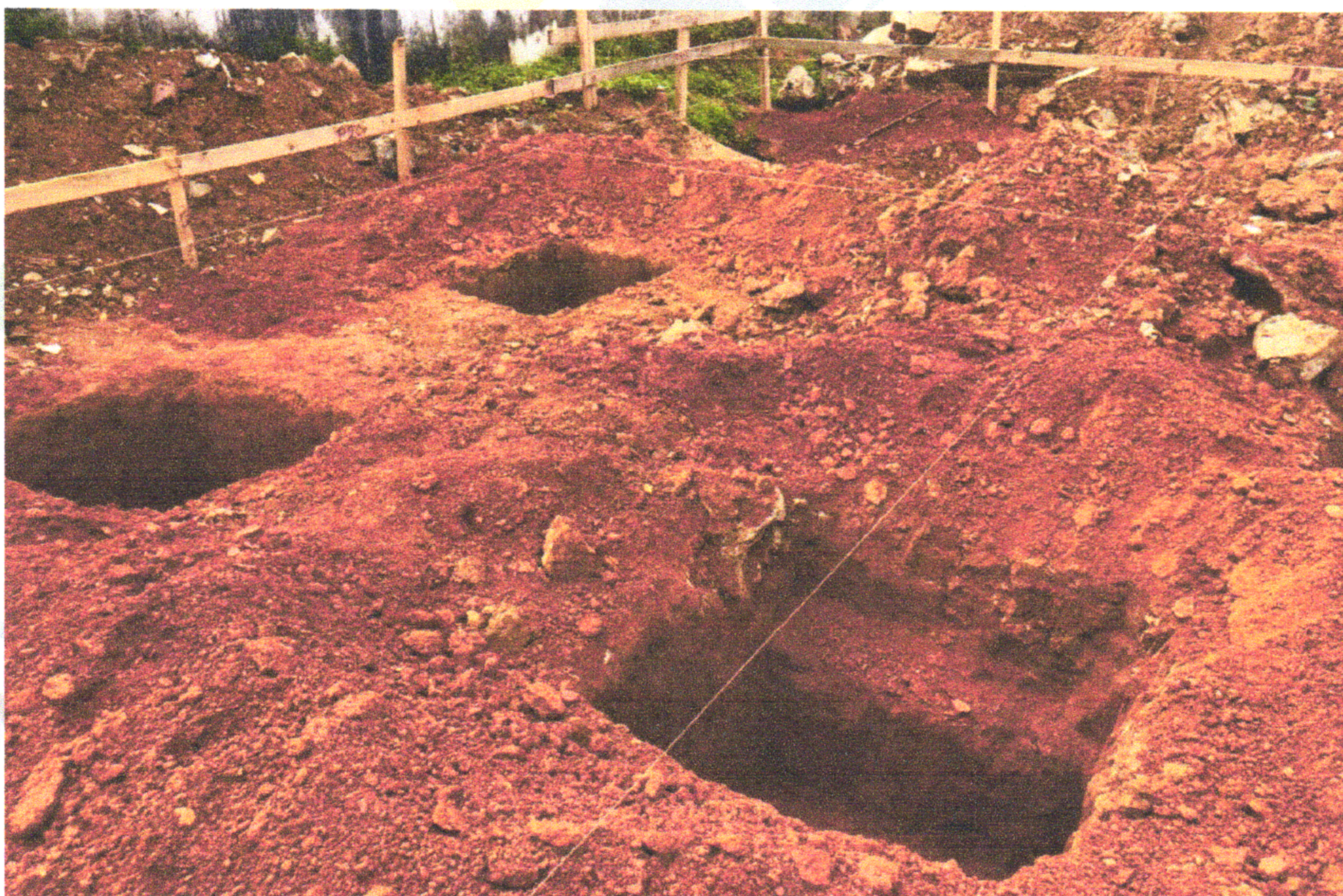
FOTO 07 (LOCAÇÃO DE OBRA E ESCAVAÇÃO DAS SAPATAS)
