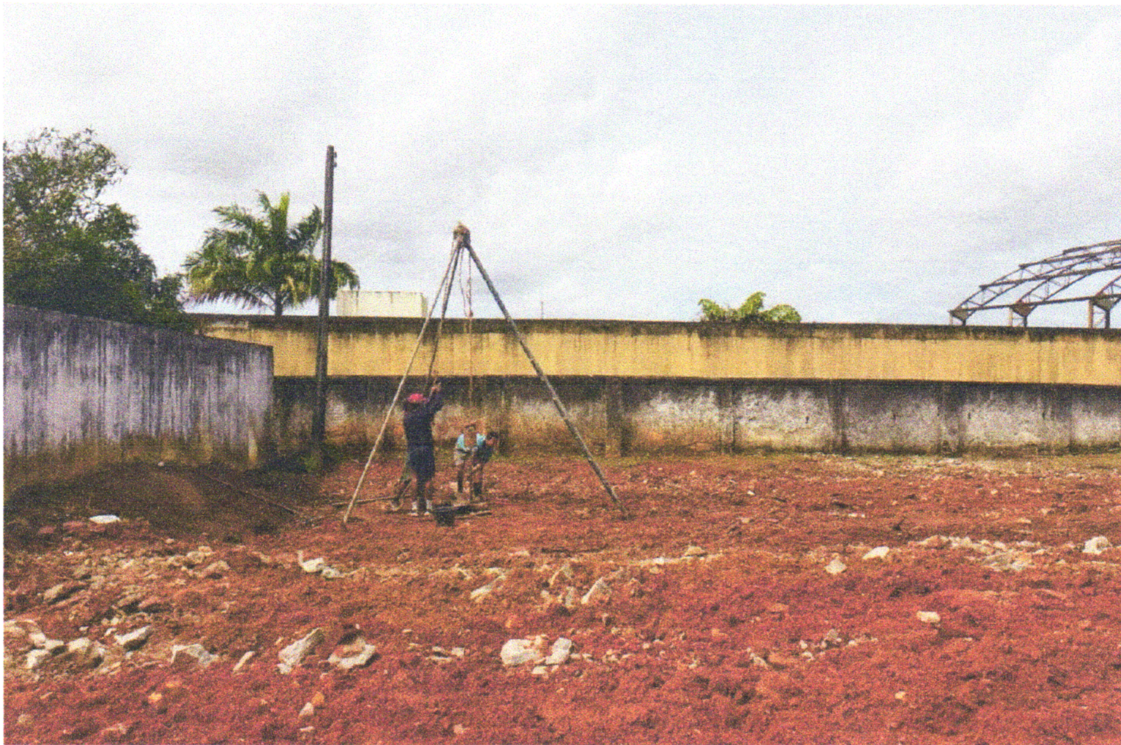
FOTO 04 (SONDAGEM DO TERRENO)
