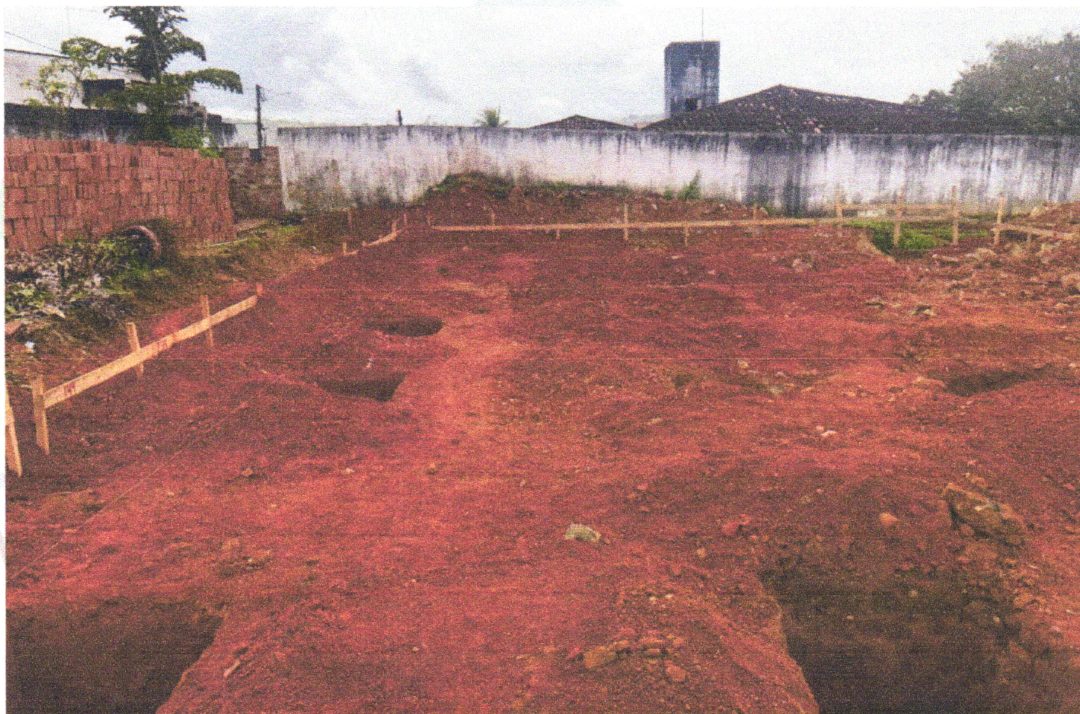
FOTO 05 (LOCAÇÃO DE OBRA E ESCAVAÇÃO DAS SAPATAS)
