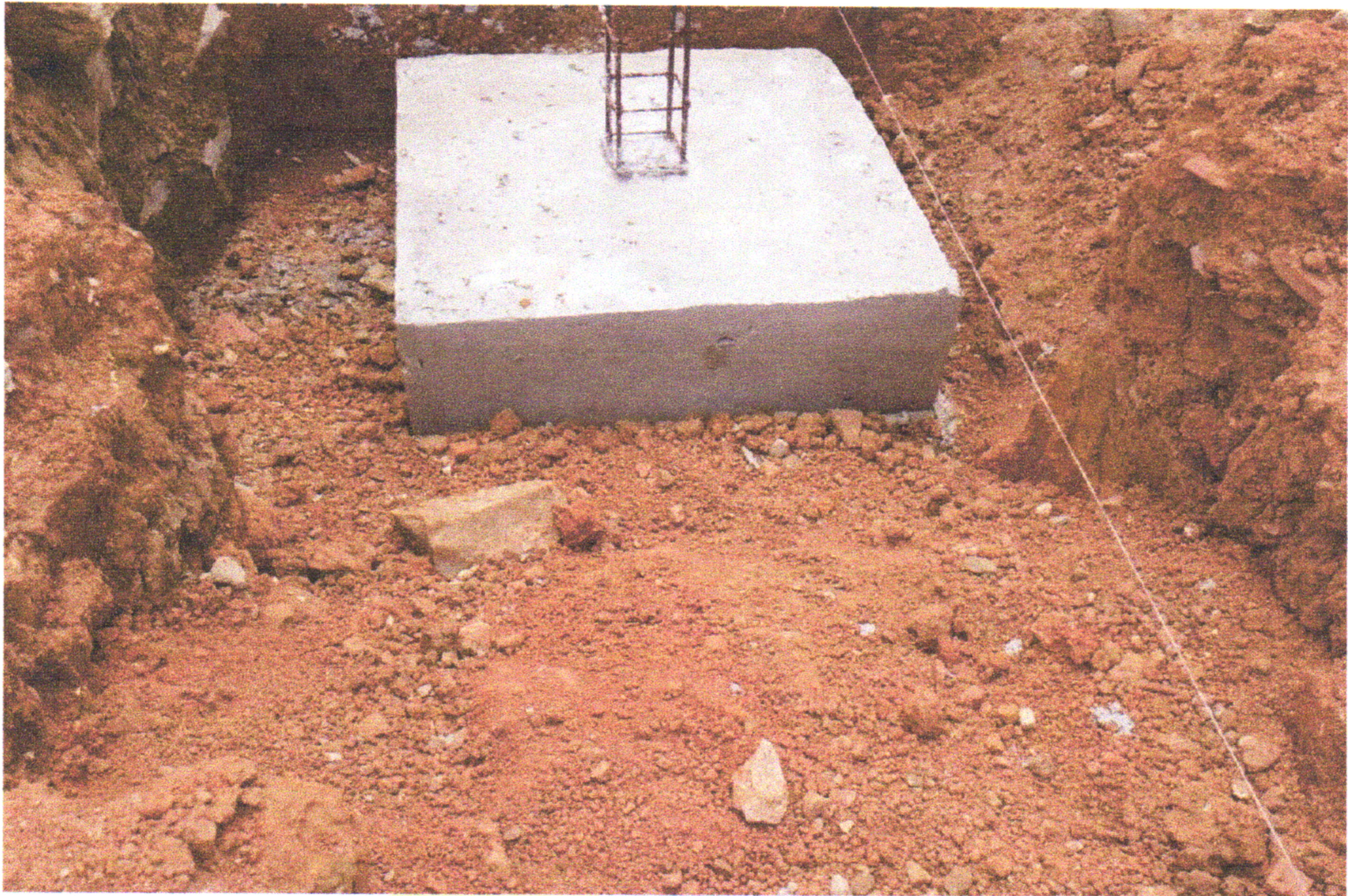
FOTO 12 (CONCRETAGEM DAS SAPATAS)
