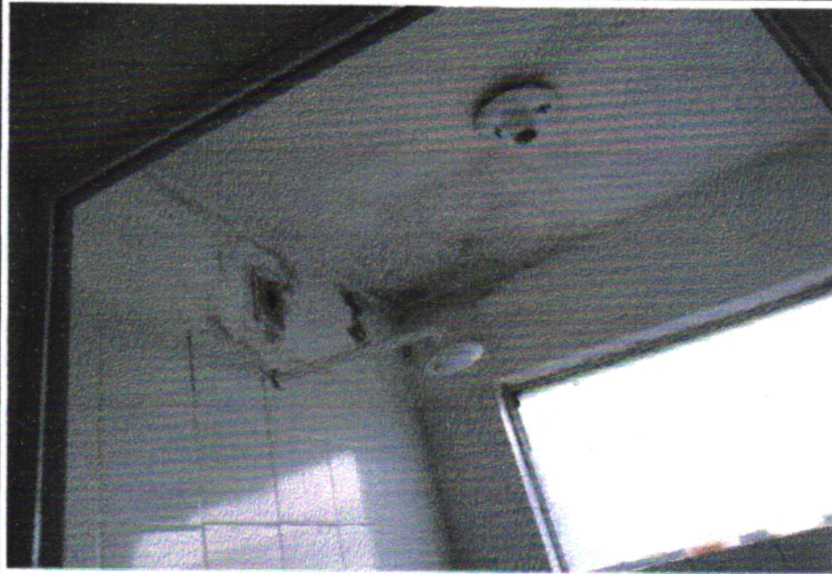
ANTES DA REFORMA
