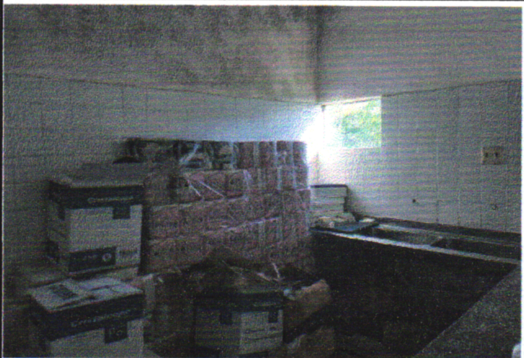
ANTES DA REFORMA
