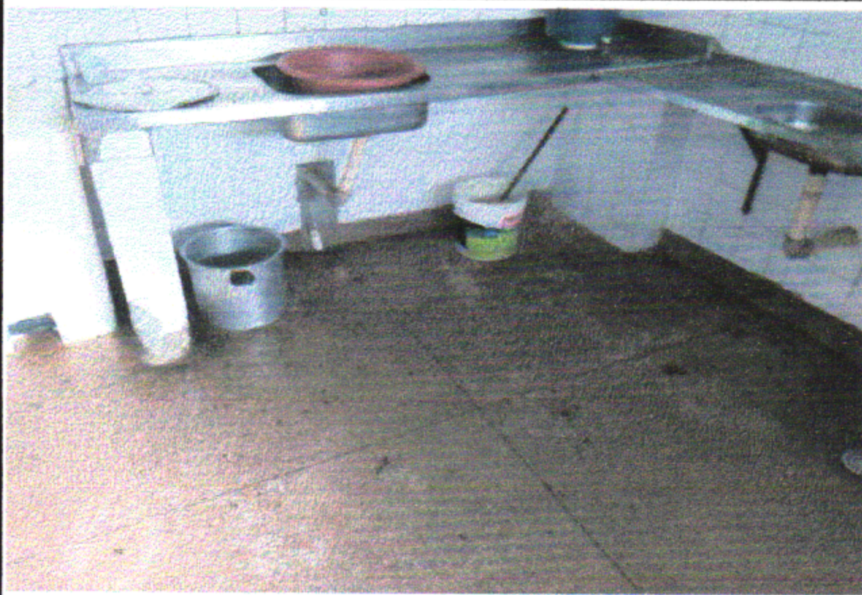
ANTES DA REFORMA
