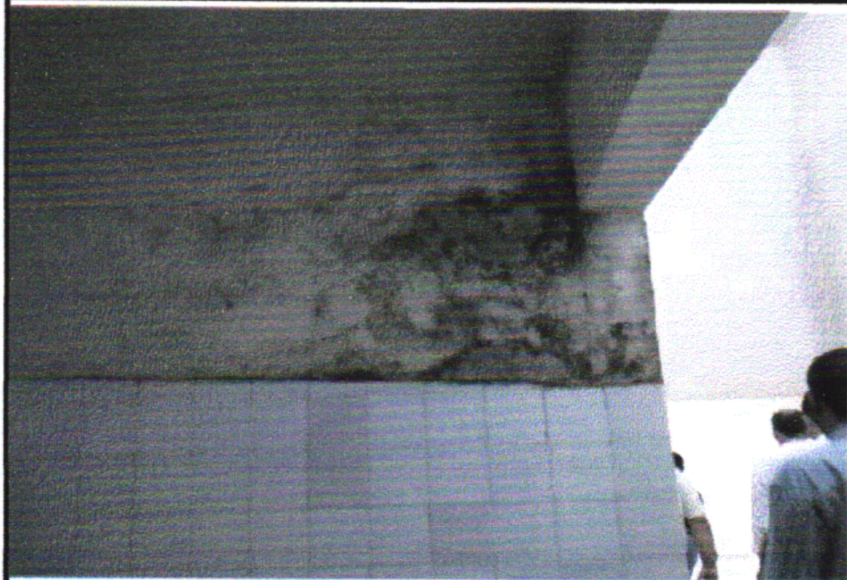
ANTES DA REFORMA
