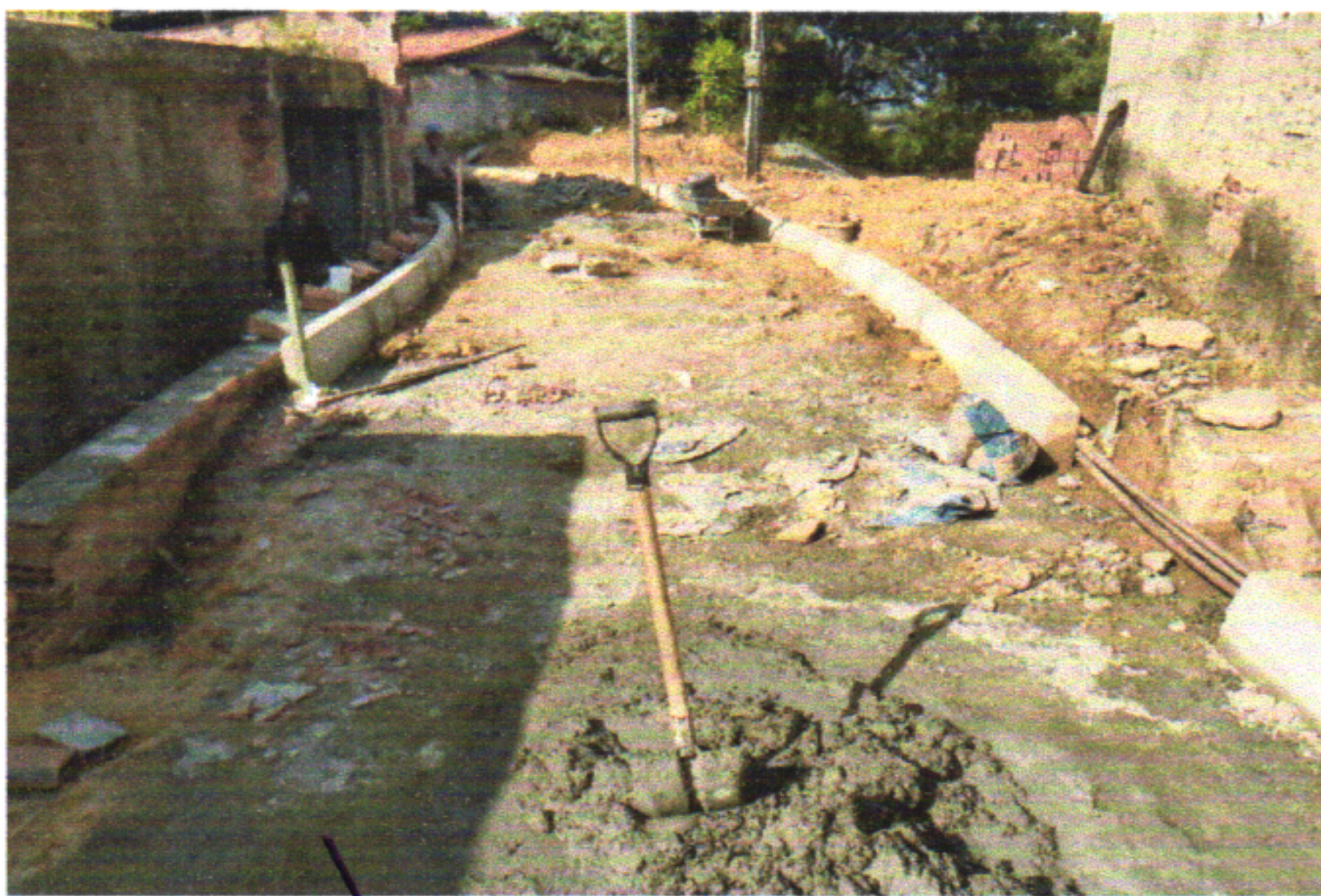
MURO DE CONTENÇÃO
