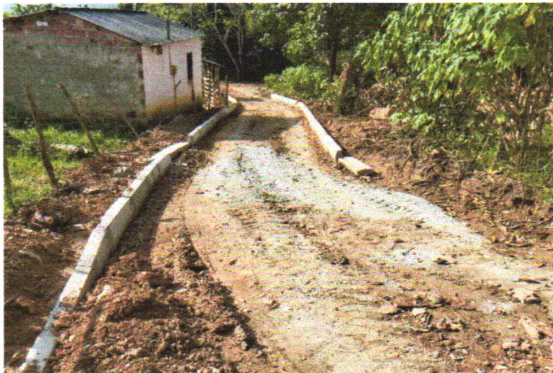
REGULARIZACAO MANUAL DE TERRENO NATURAL, CORTE OU ATERRO ATE 20 CM DE ESPESSURA.
