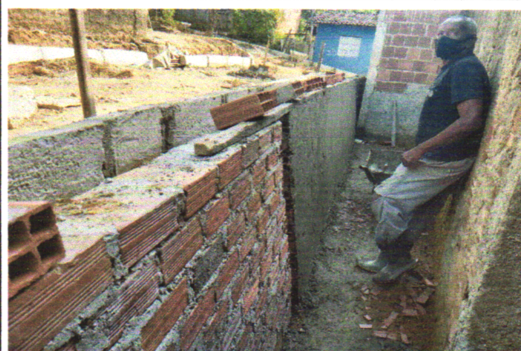
MURO DE CONTENÇÃO
