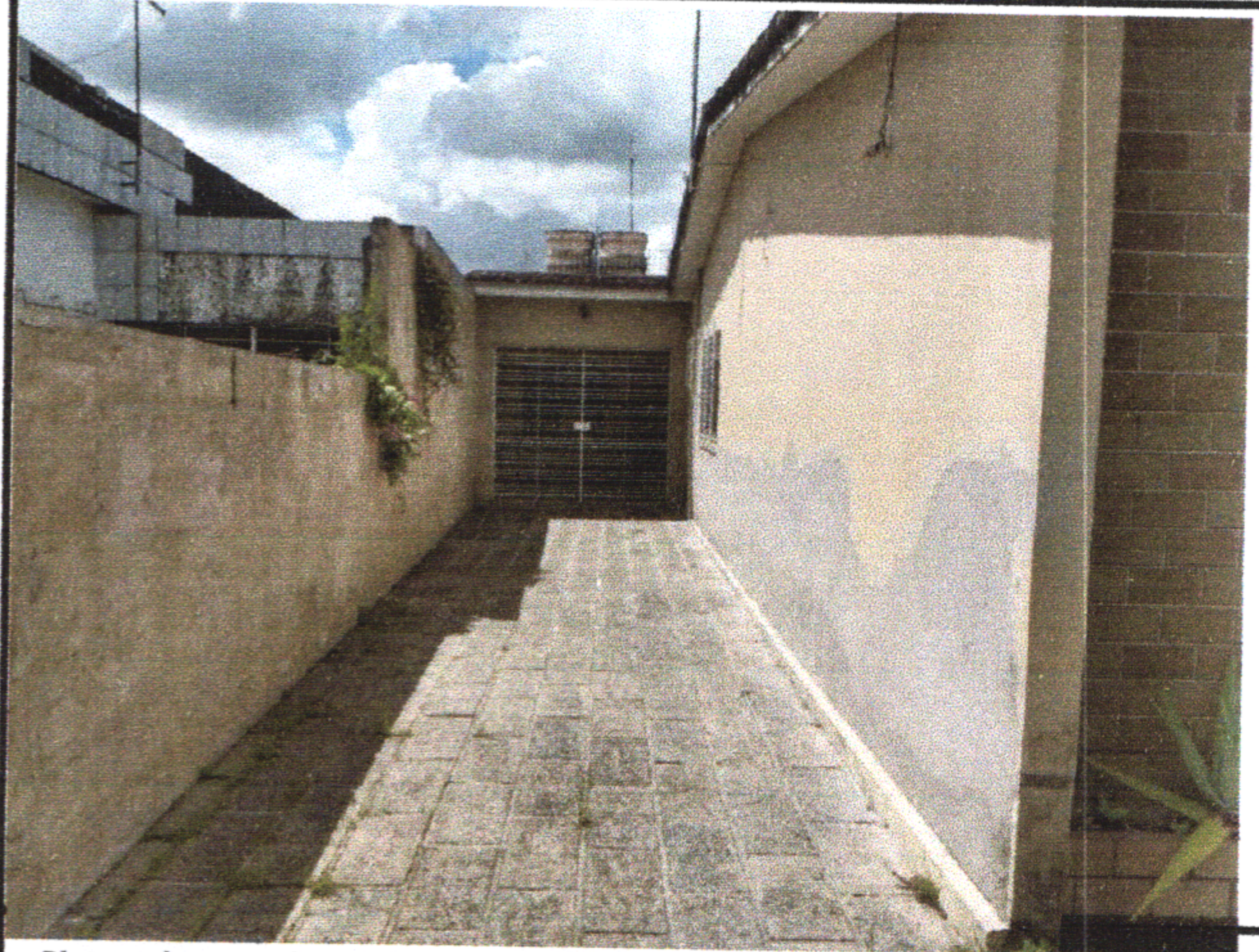
Pintura do muro da garagem apresenta mofo e parede da casa foi feito recentemente um reboco
