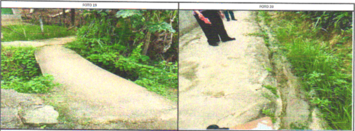
VIELA DA 2ª TRAVESSA SEVERINO PEDRO MARCOLINO TRAVESSA CAPIBA
